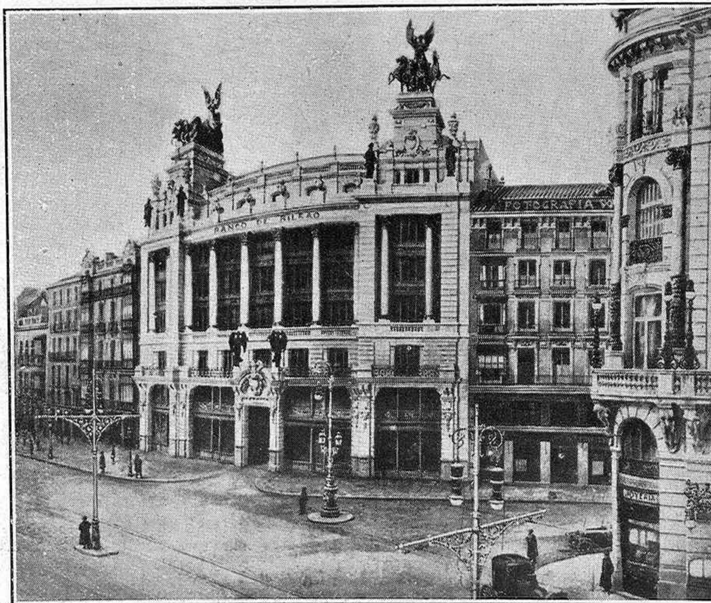
Edificio del Banco de Bilbao, que se construirá en la esquina de las calles de Sevilla y de Alcalá, según proyecto del arquitecto Sr. Bastida. Será un edificio mixto, del que la parte principal se destinará al Banco y la restante á oficinas particulares. Su coste se calcula en cinco millones de pesetas
