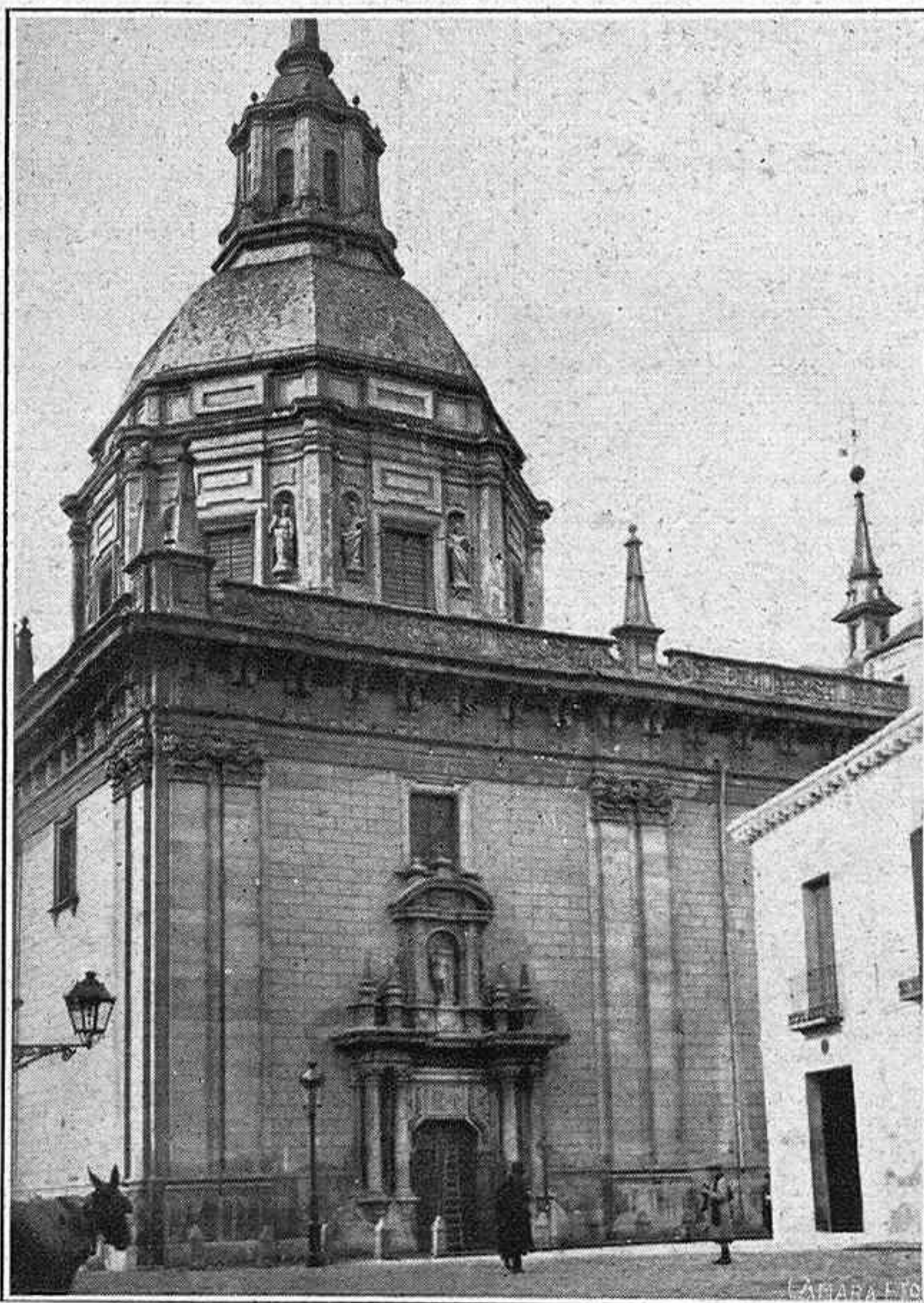
Exterior de la iglesia de San Andrés
