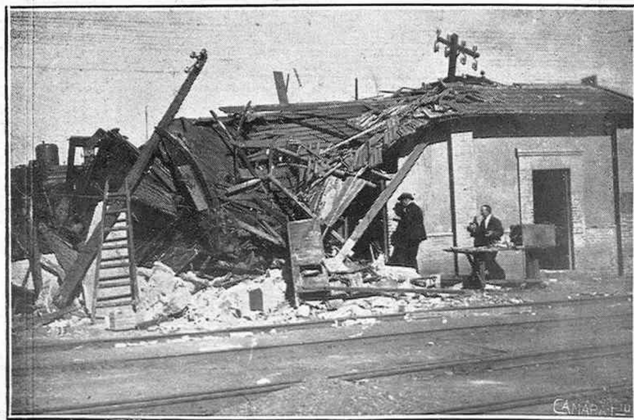
Caseta de clasificación, sobre la que saltó el coche-cama del expreso de Andalucía
