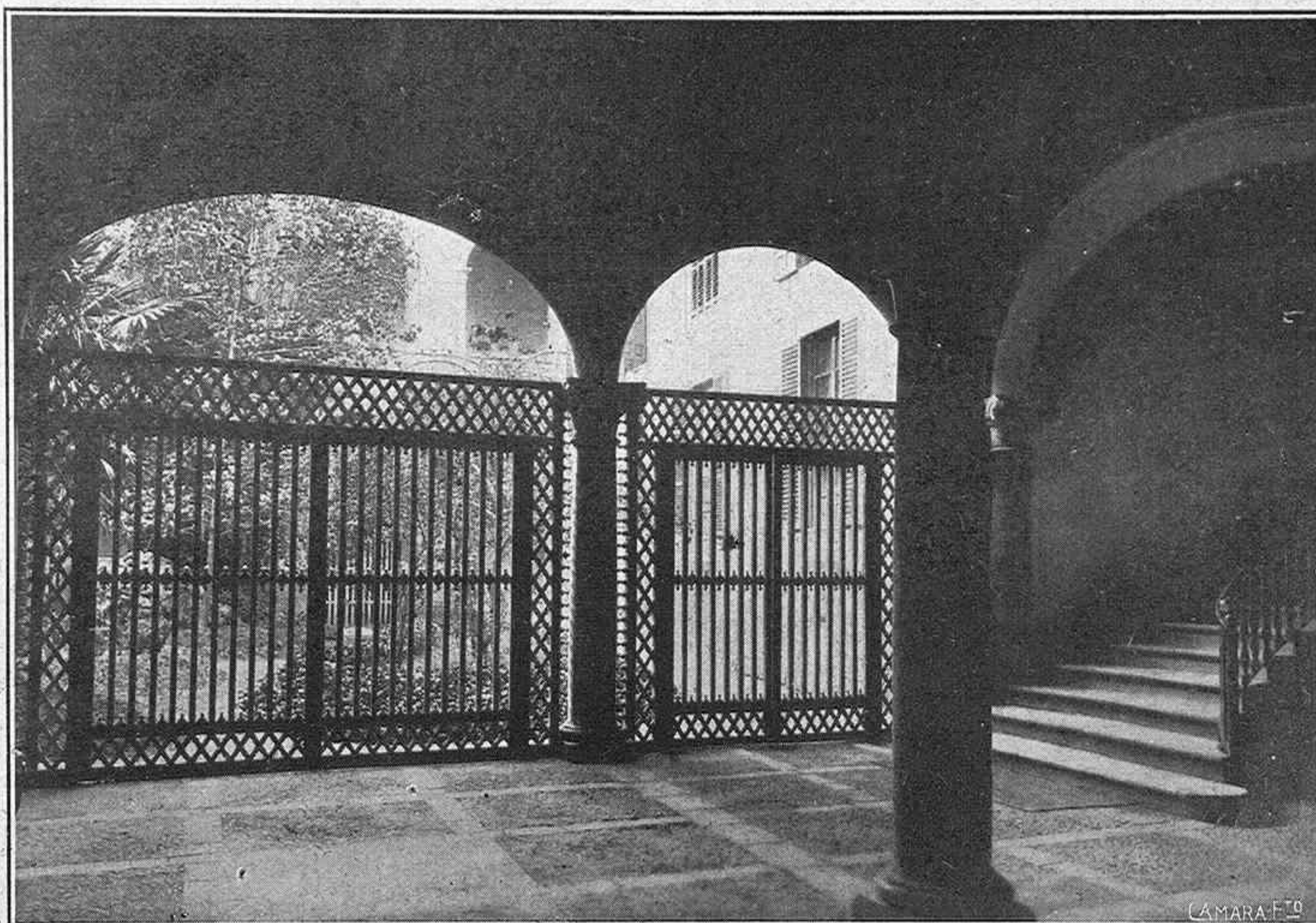
Patio de la casa Moroto
