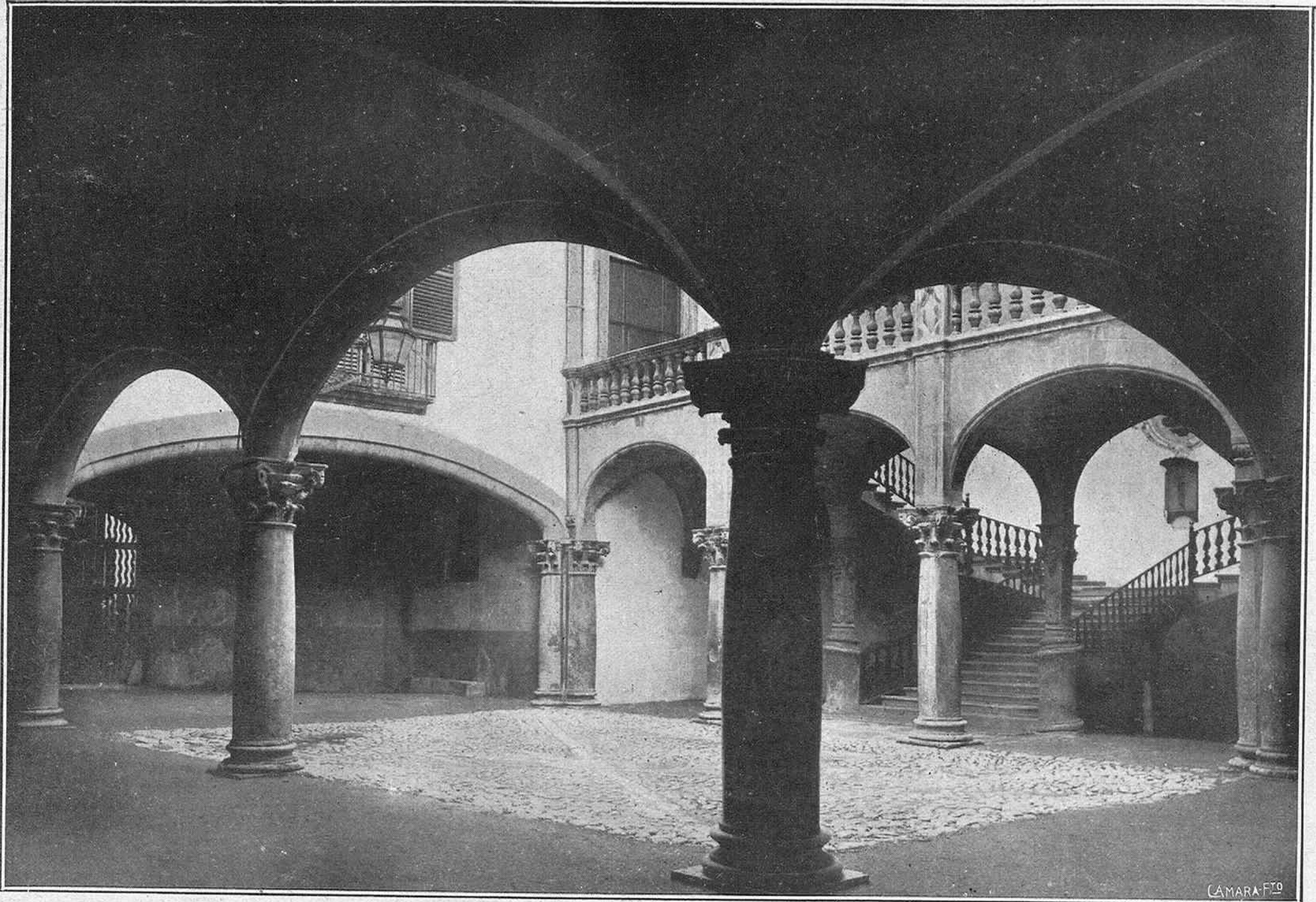
Patio de la casa del marqués de Nivot
