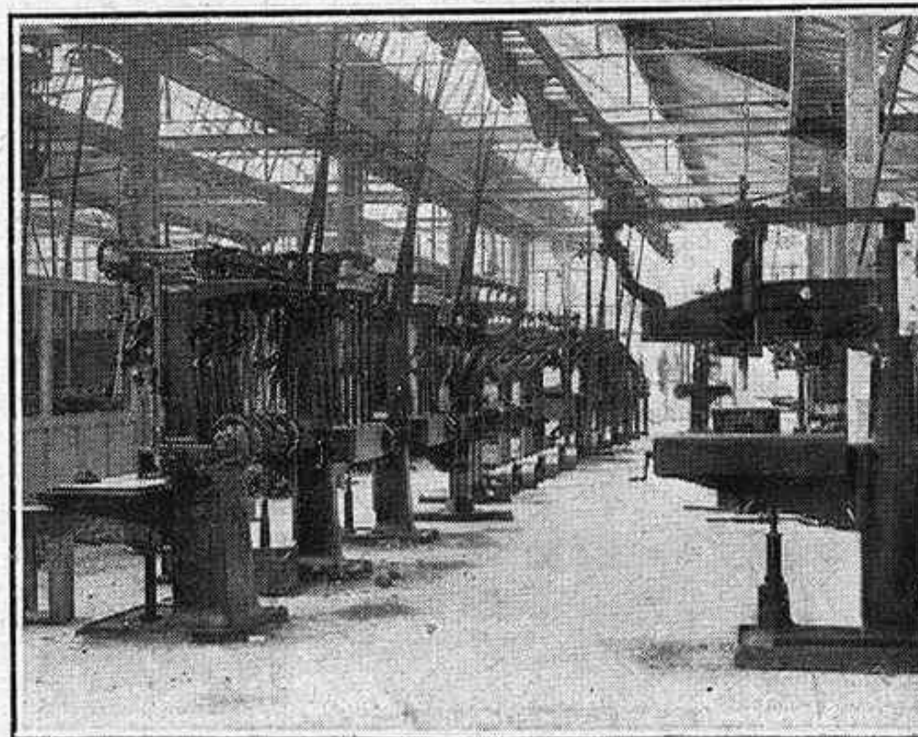
Sección de máquinas perforadoras FOTS. GOÑI
