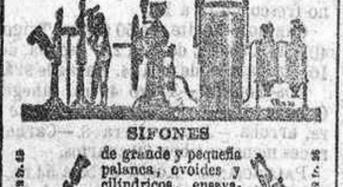
SIFONES de grande y pequeña palanca, ovales y cilindricos, ensayados a una presión de 30 atmósferas. Sencillos, sólidos, fáciles de limpiar.
