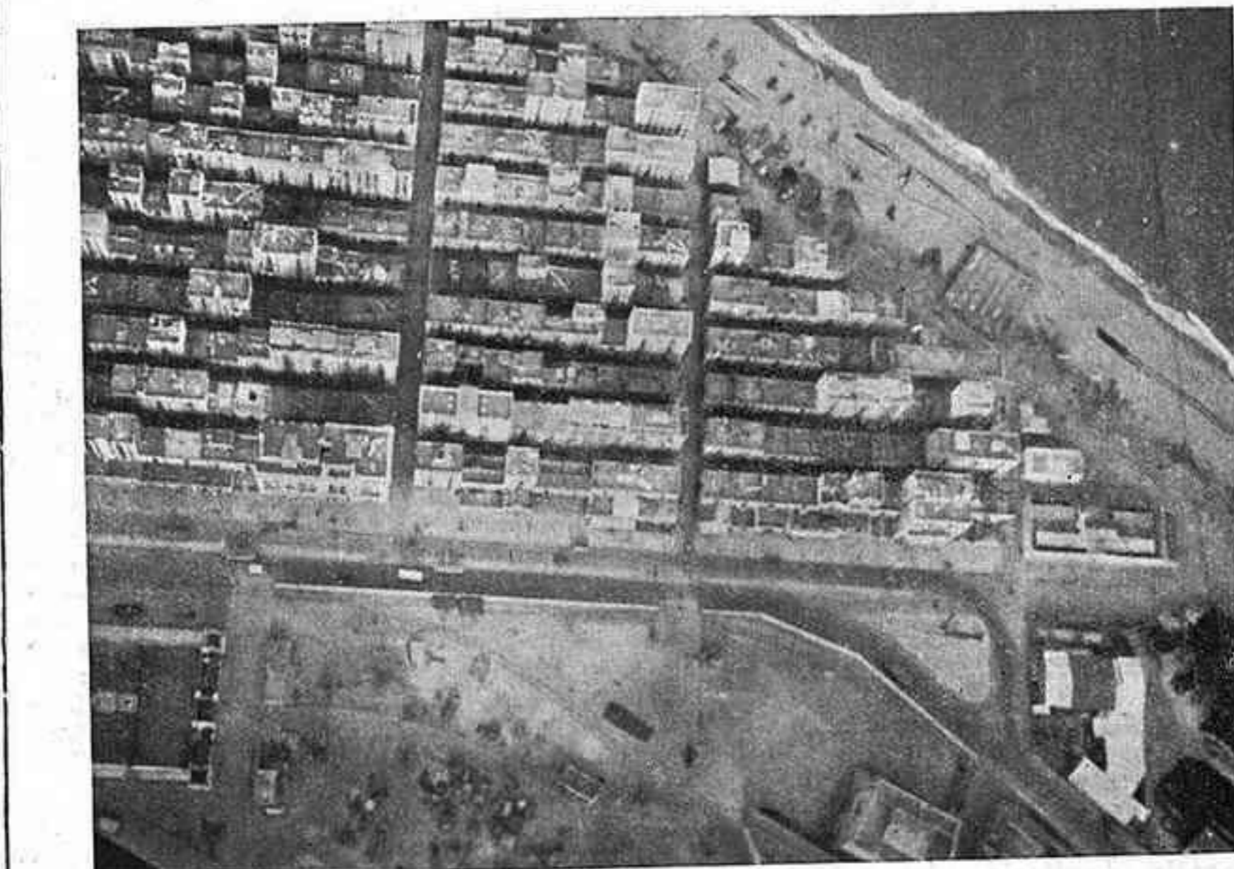
4. — La Barceloneta, que s'omple d'edificacions altes
