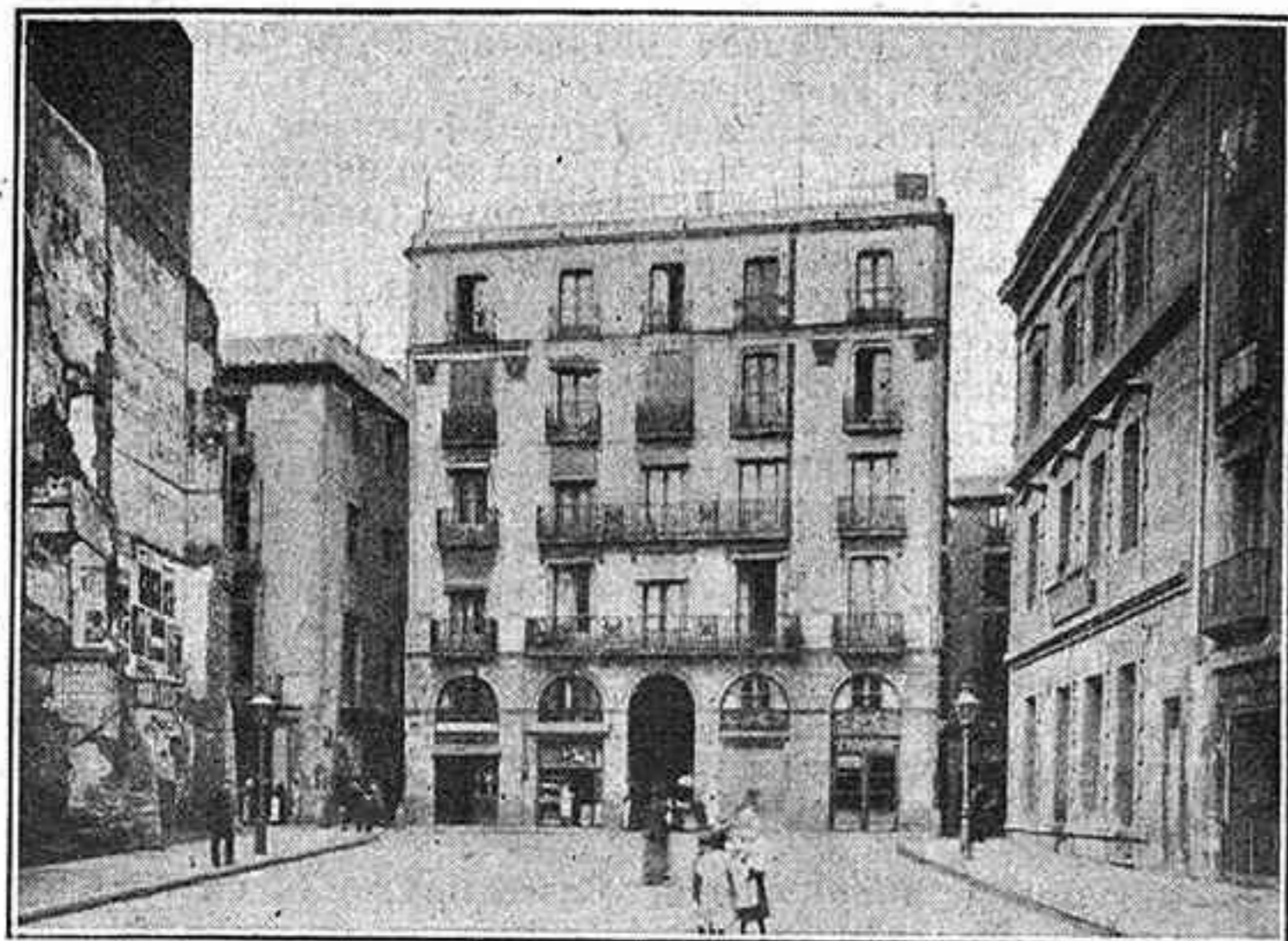
Casa del carrer Ample per la qual comensaren els treballs d'enderrocament.
