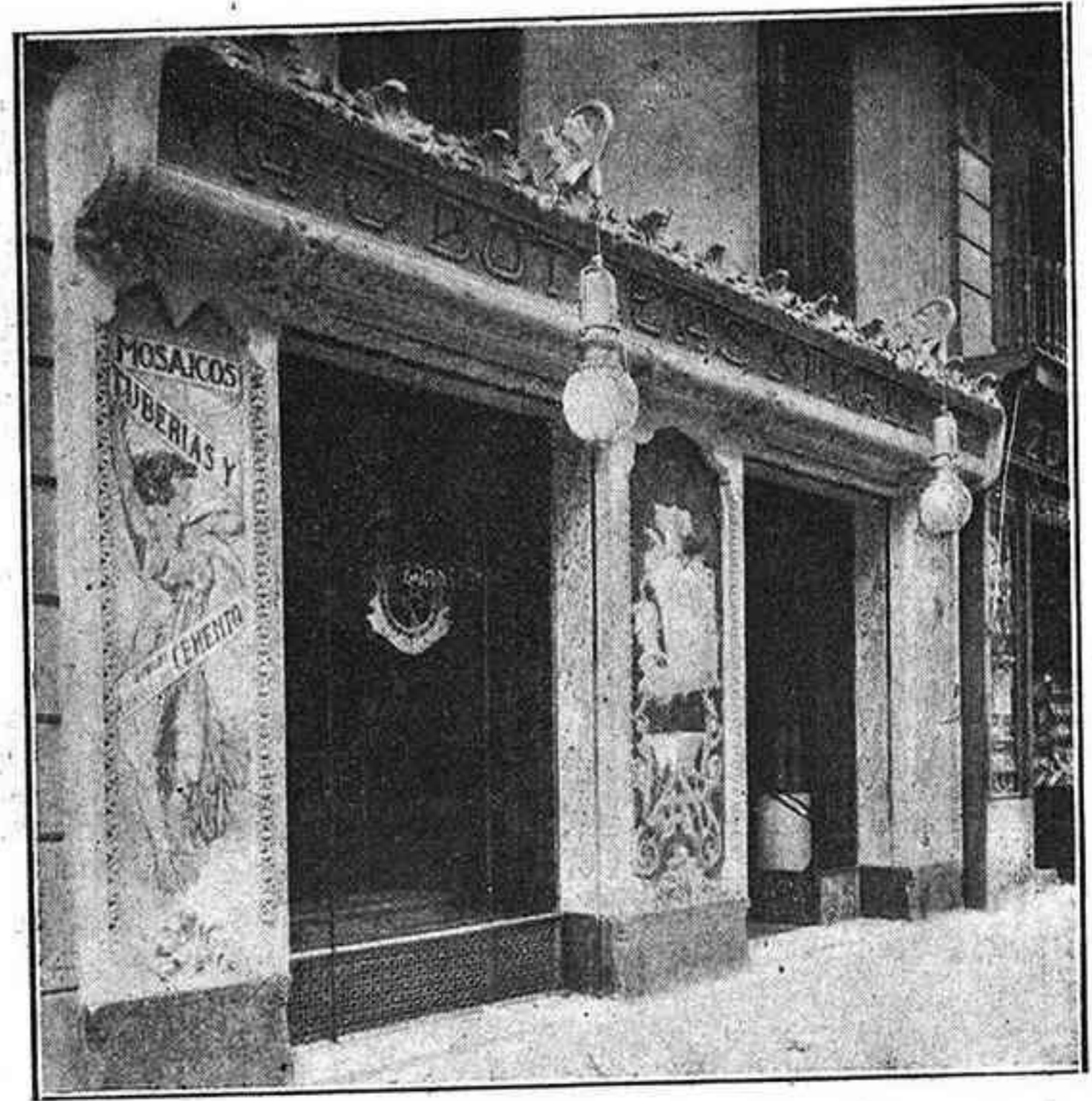
Despaig de la casa Butzems y Fradera (carrer de Pelayo).
