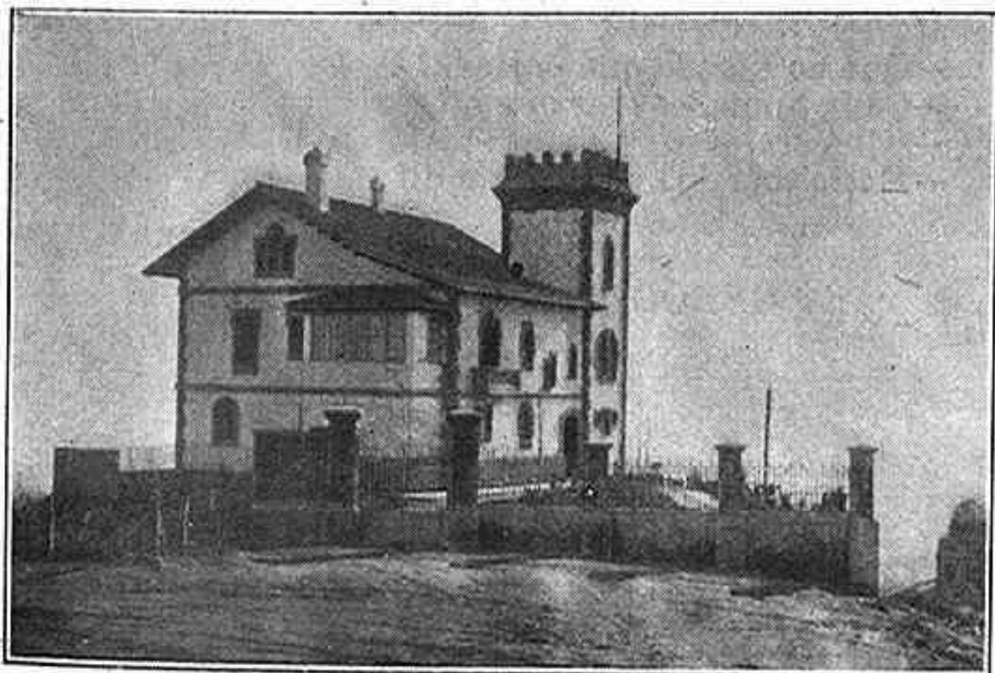
Vista general del edifici, situat al peu del baixador del Observatori.
