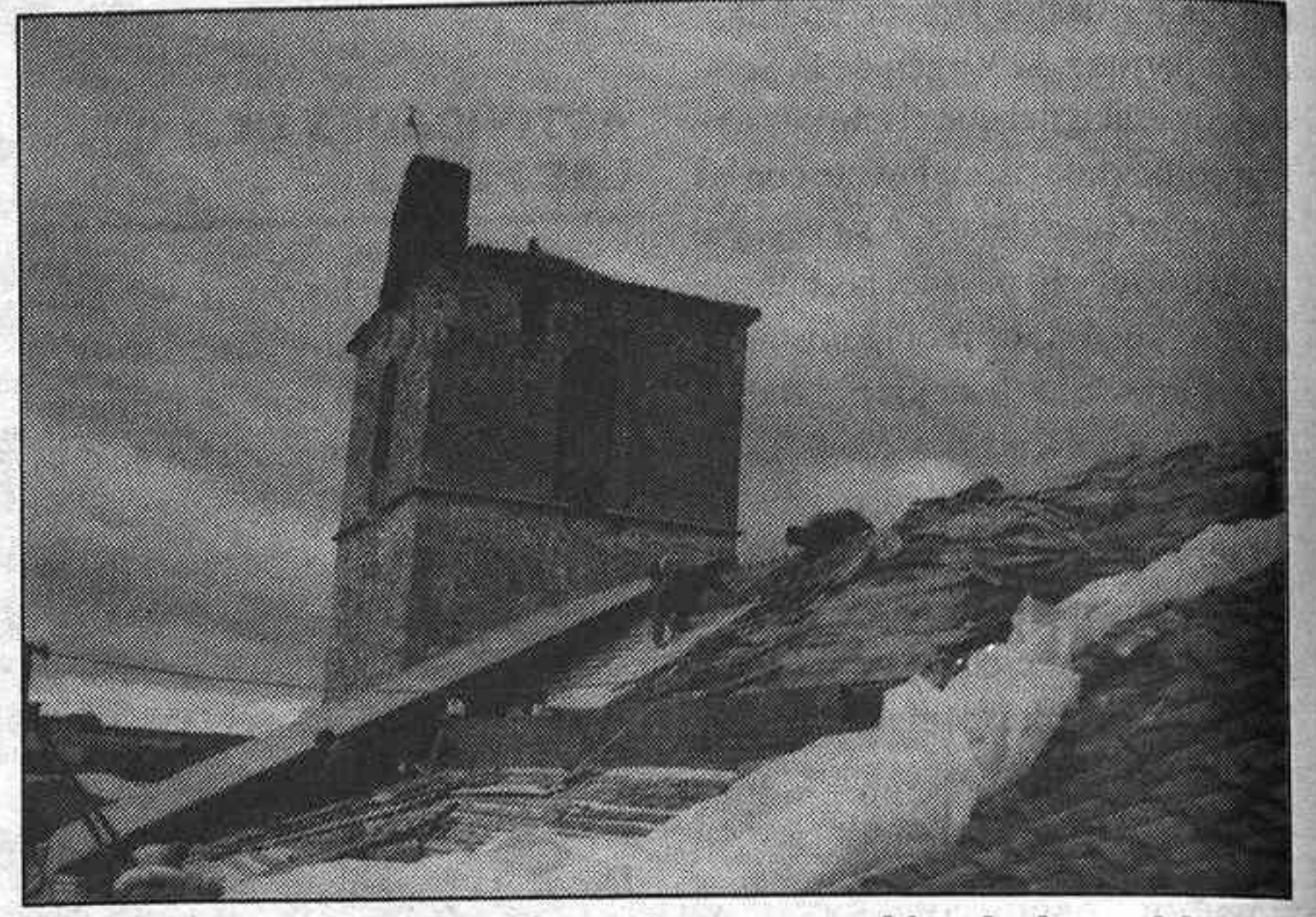
Voluntarios trabajando en la reparación de la cubierta
