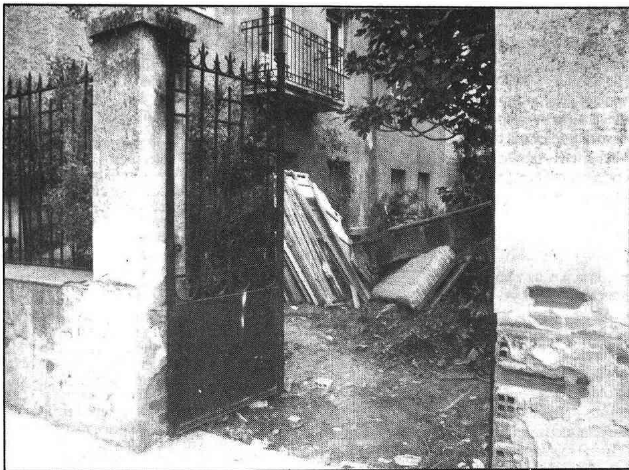
Muebles viejos y otros enseres de la Asociación de Jubilados aparecieron en la mañana del miércoles, arrojados en el jardín anexo. Paralelamente, CC.OO. iniciaba las obras de ampliación de su edificio
