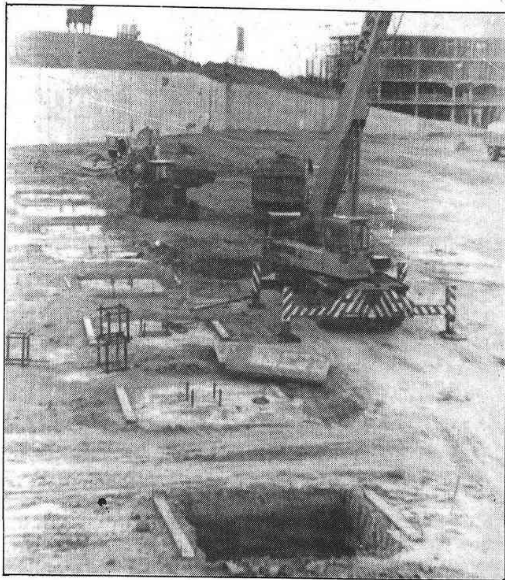
Las obras marchan a todo ritmo
