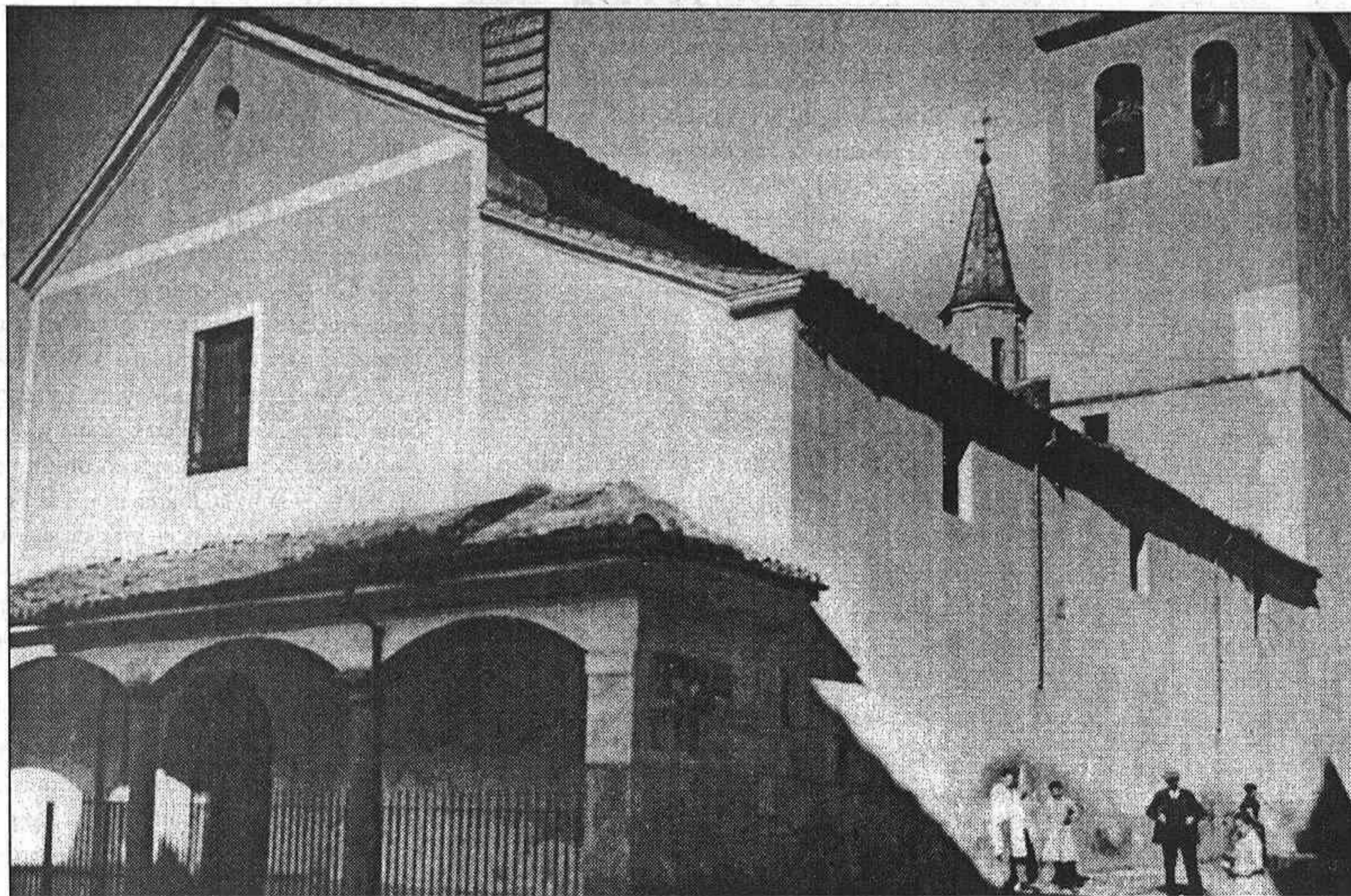
Iglesia de San Gil antes de su demolición
