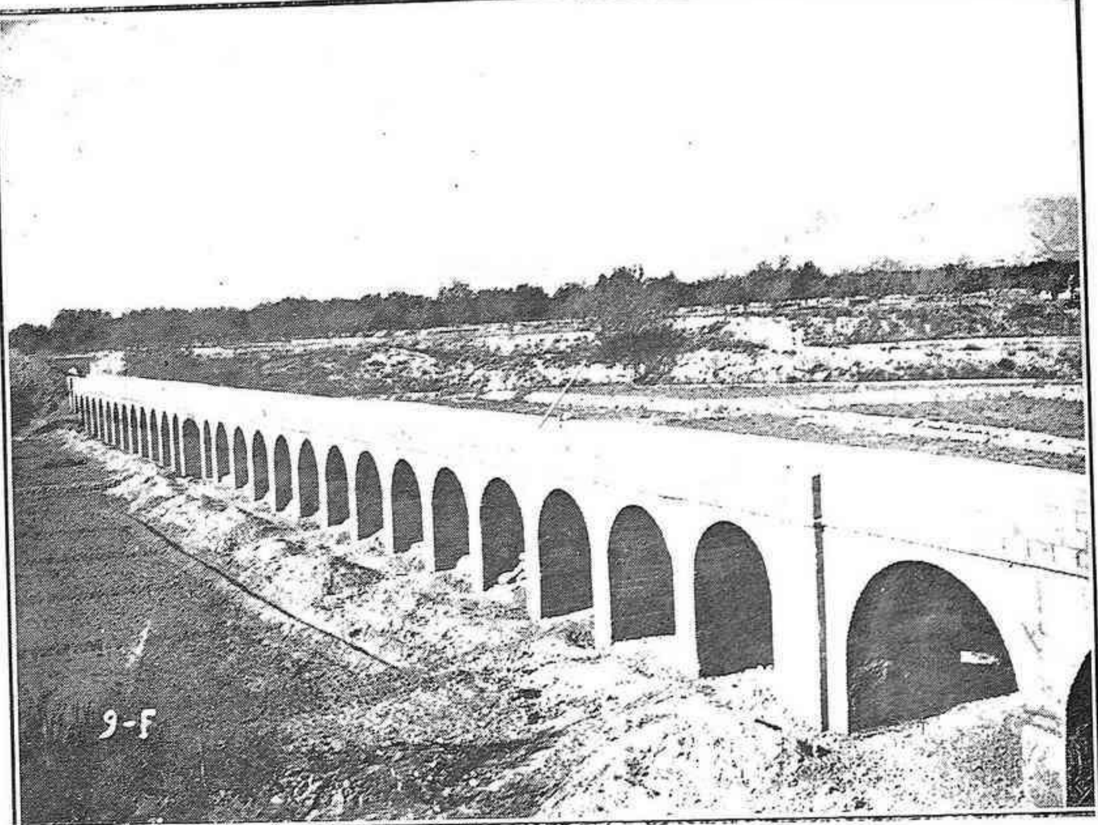
Segundo canal transversal de Poniente. Acueducto sobre el barranco del Box.
