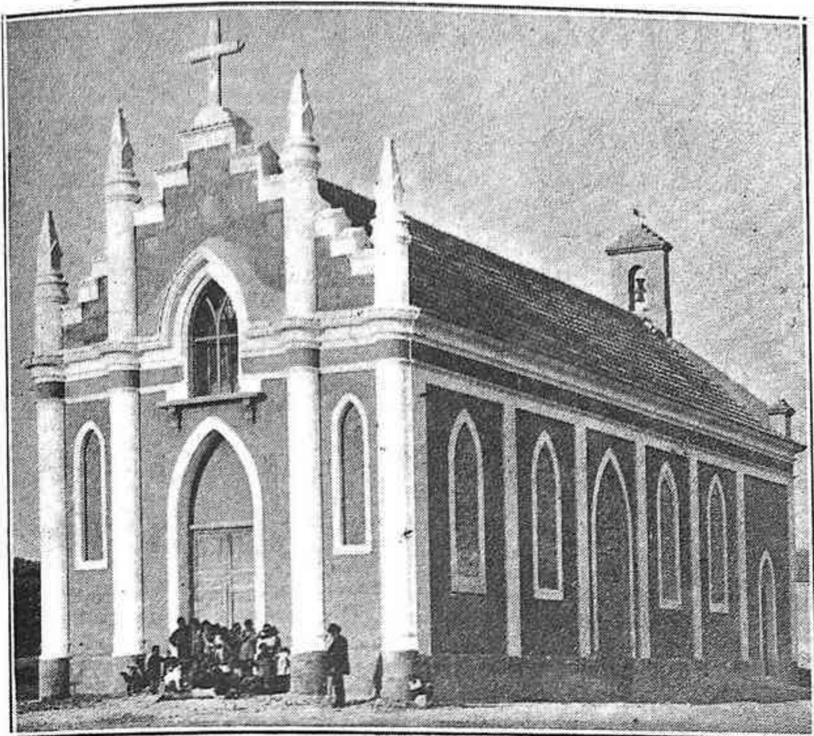
TORREVIEJA, — Hermosa Capilla del Sagrado Corazón de Jesús recientemente edificada merced a generosas donaciones de piadosas personas de Torre vieja y Orihuela y algunos otros veraneantes, situada en la plaza del Conde de Vía-Manuel, antes Plaza da Oriente.
