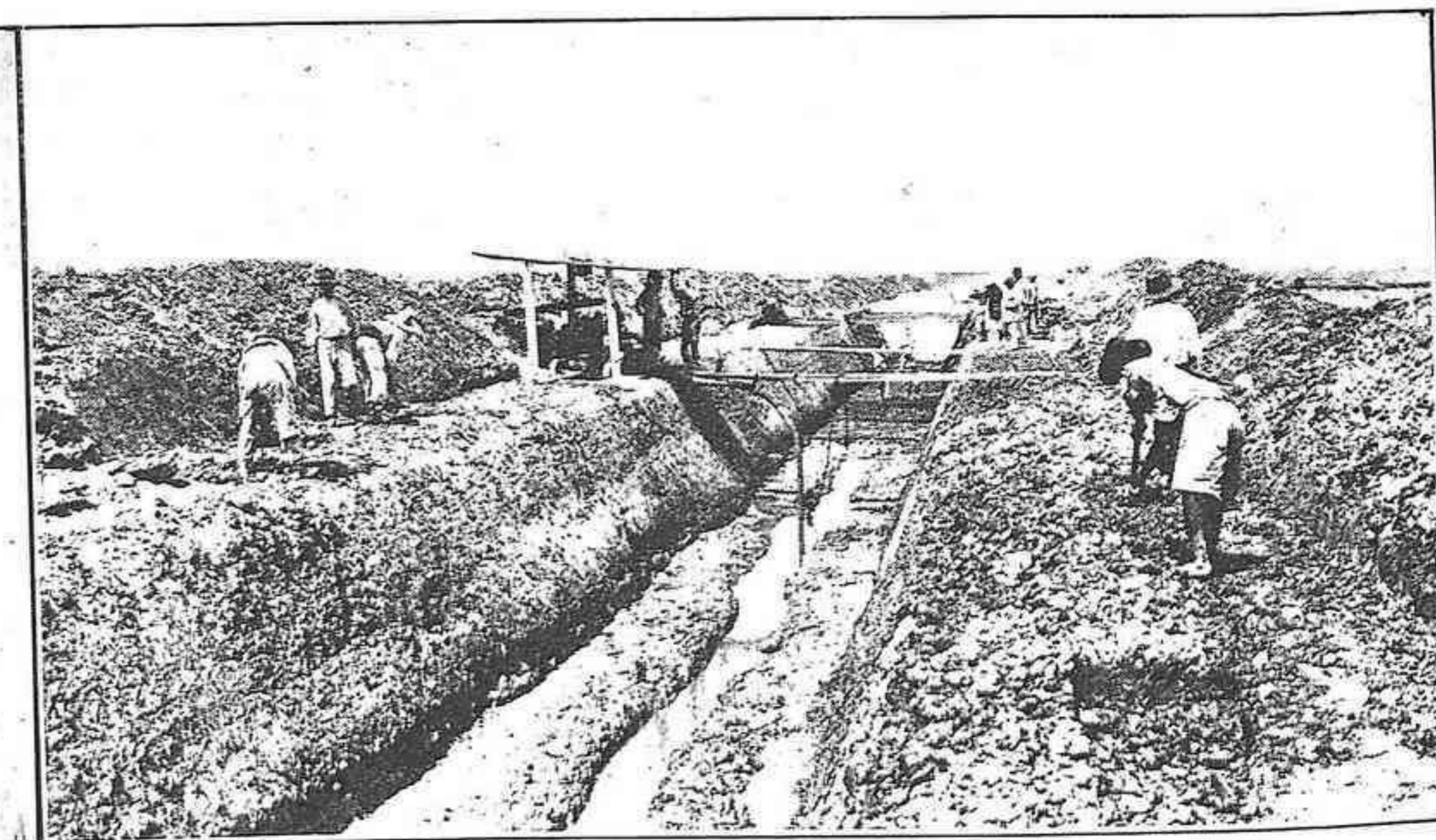
Construcción del canal general de conducción: saladares.
