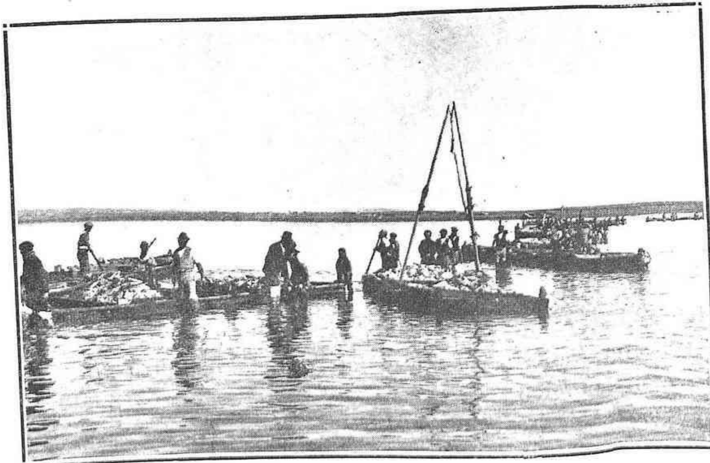
Grupo de trenes (unión de lanchones) cargados de sal disponiéndose a tomar el cable que los conduce a los lavaderos
