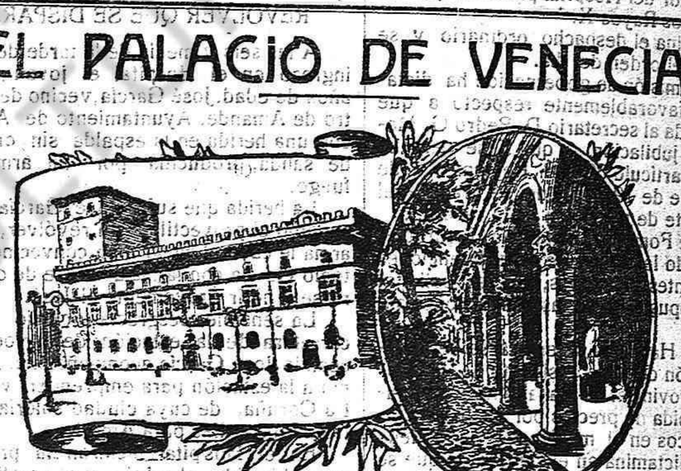
Fachada principal. Hermosa arcada del patio principal.
