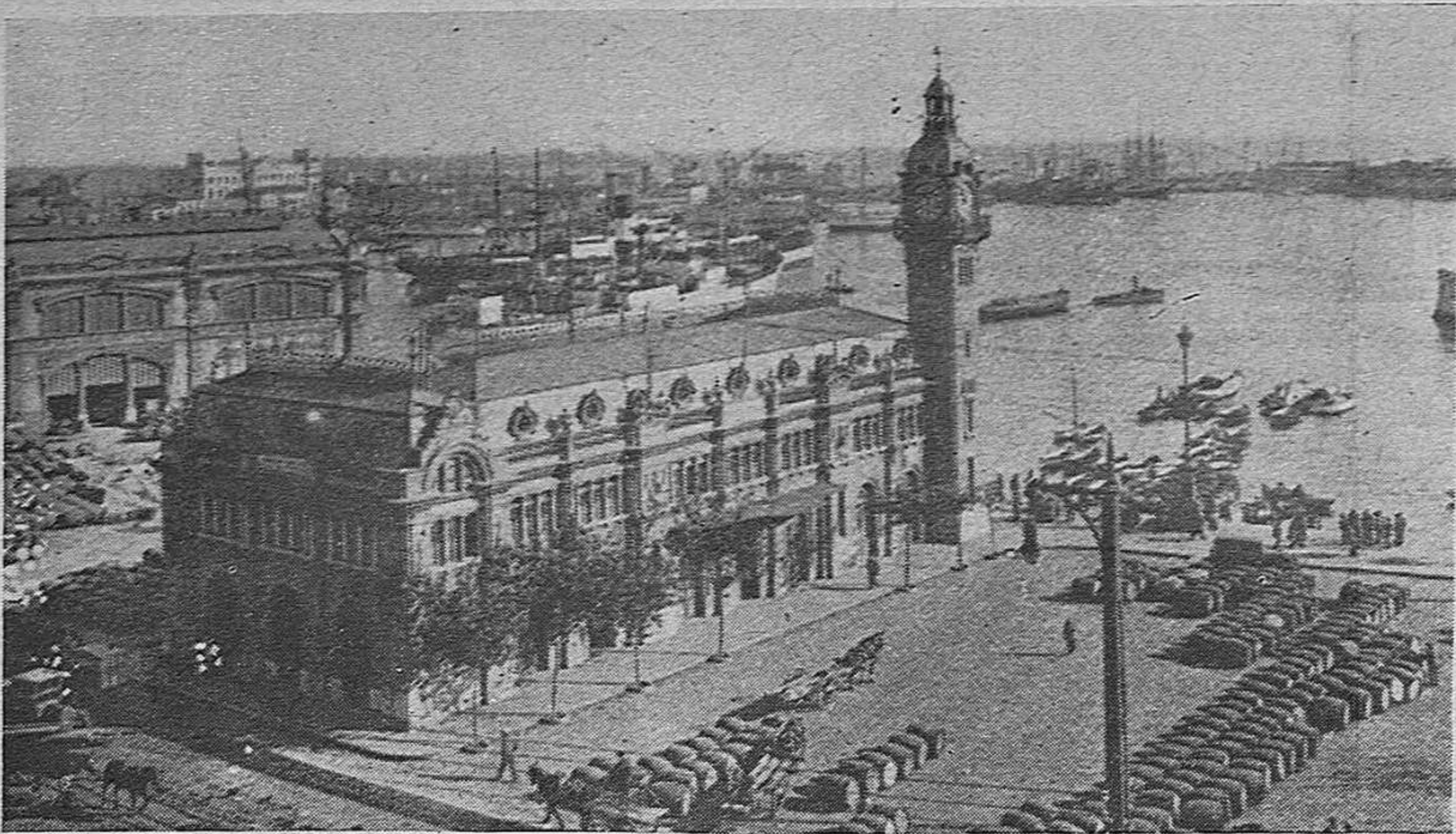
Una vista del Grao, puerto de la capital valenciana, donde bajo el influjo de las negociaciones yanqui-franquistas, se están llevando a cabo importantes obras de dragado y construcción de diques.
