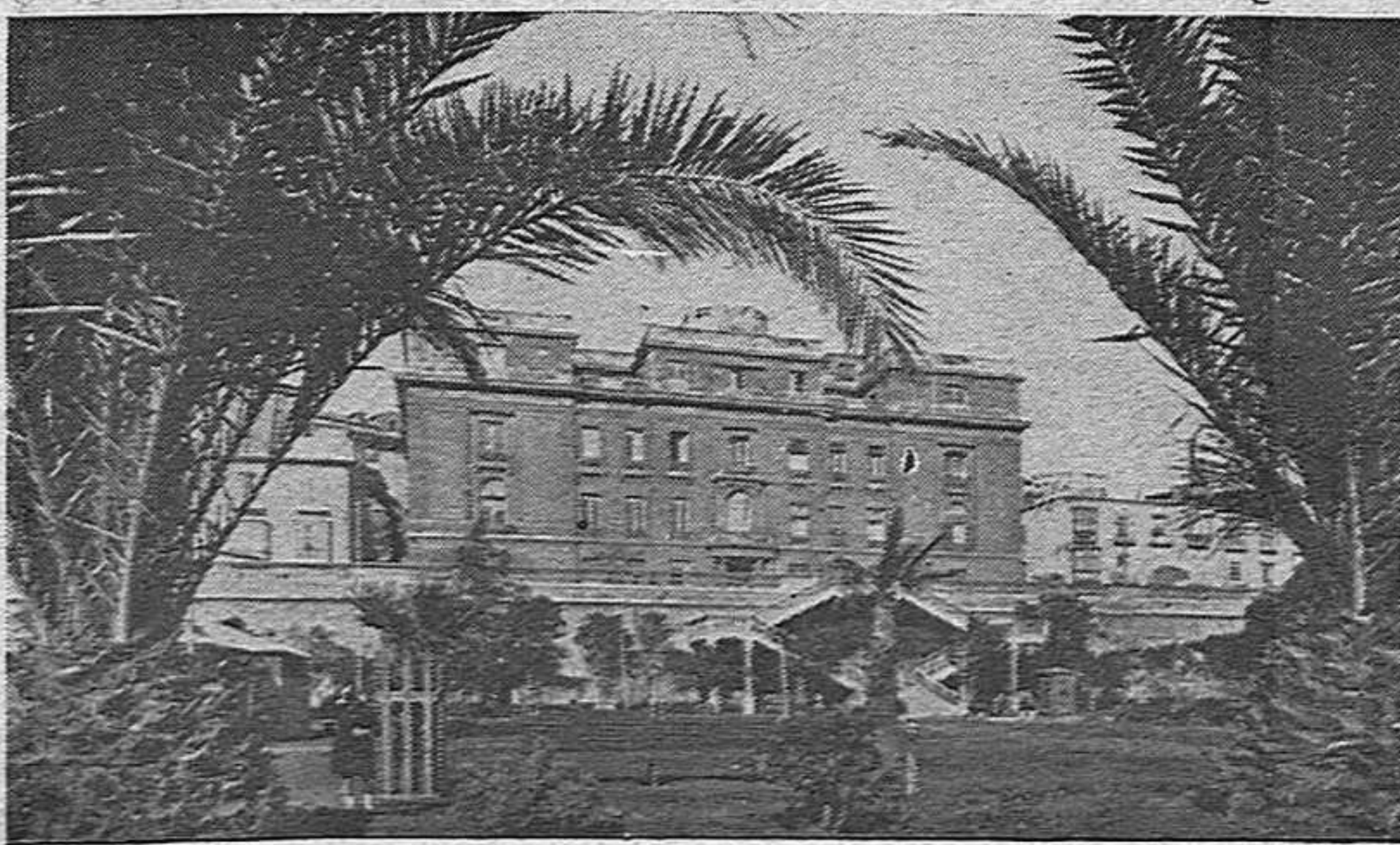
Cartagena. Edificio de la Intendencia y del Cuerpo Administrativo de la Armada.
