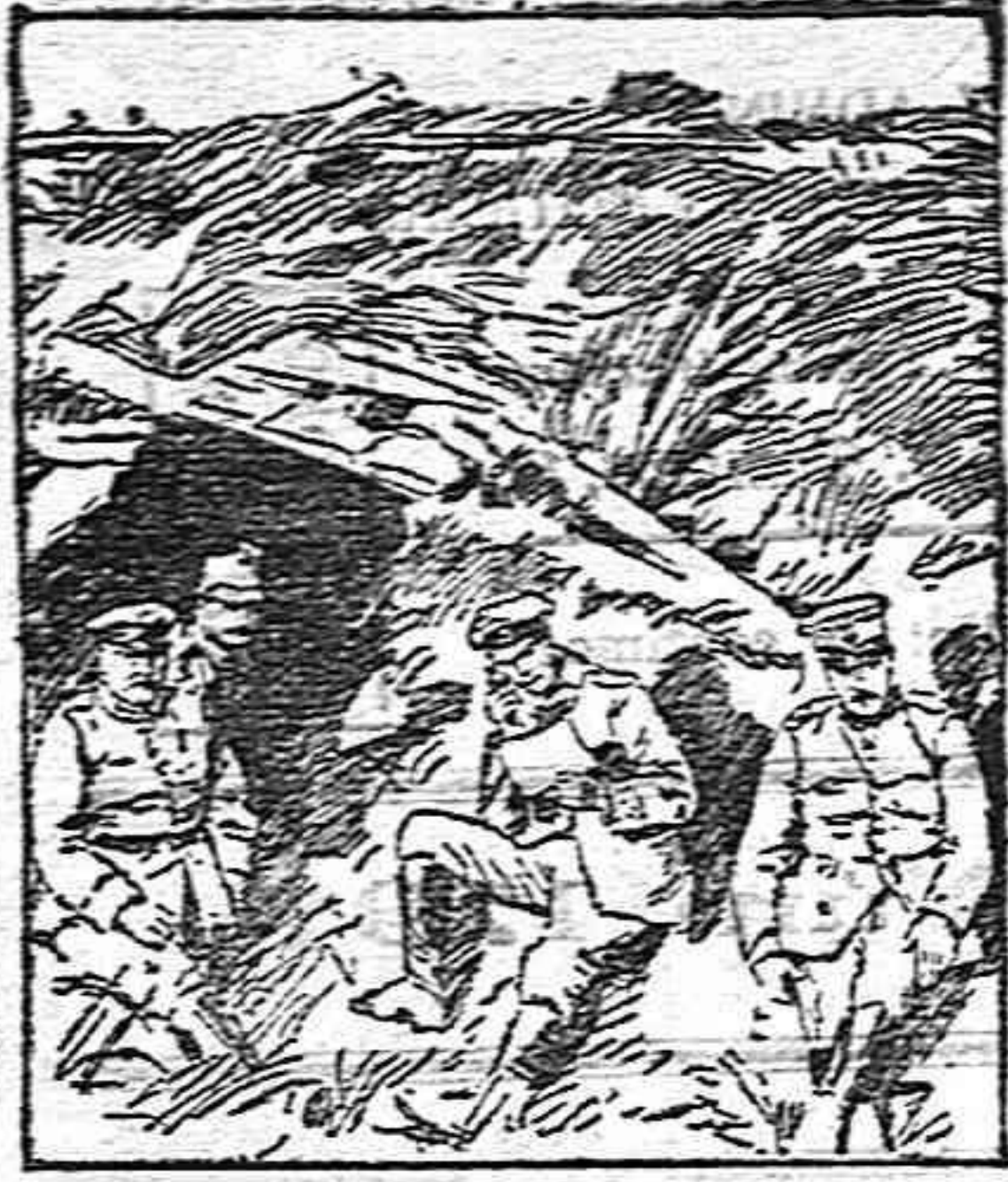
Estación telefónica en las líneas alemanas.
