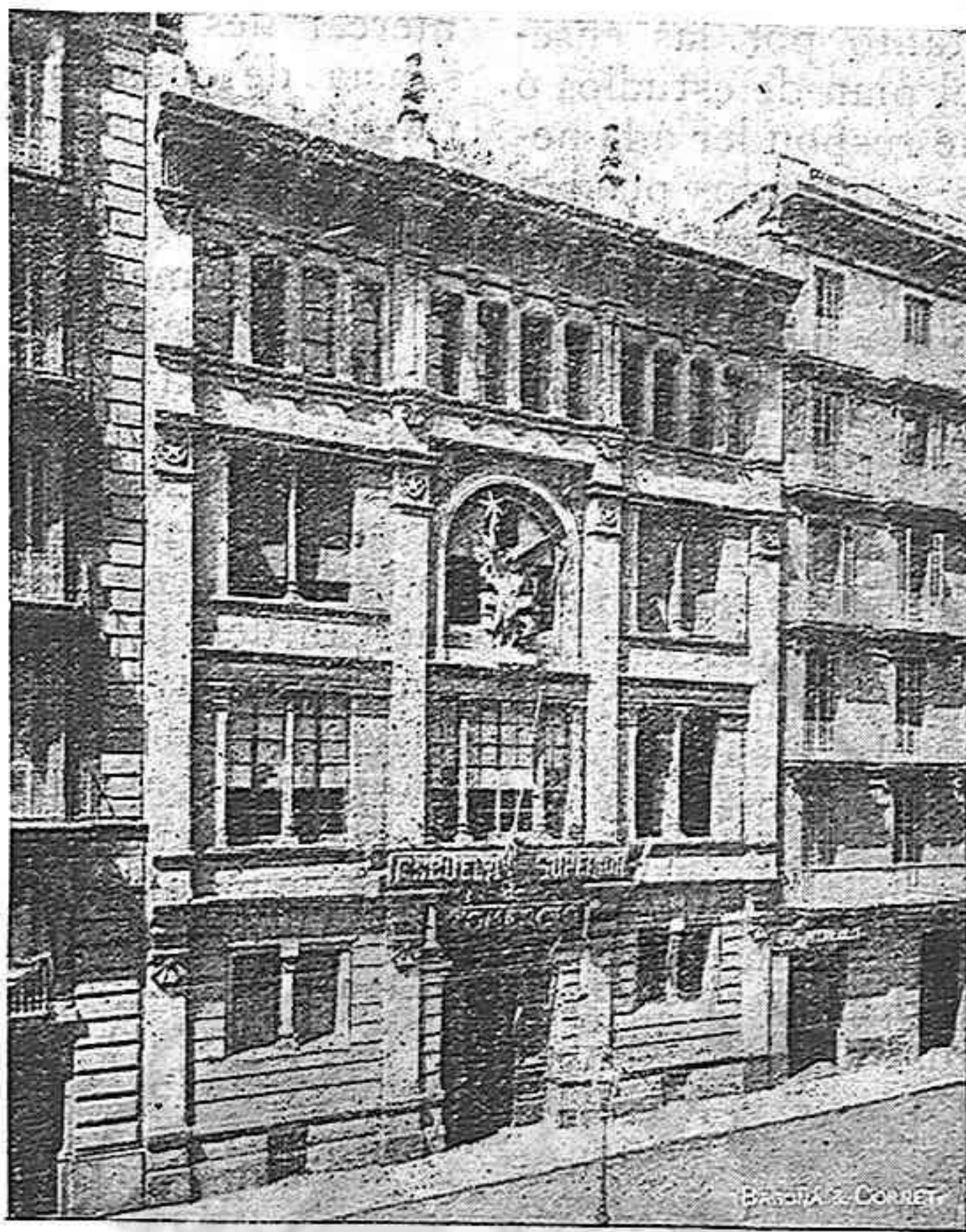
Local que ocupa la Escuela Superior de Comercio de Barcelona; calle de Balma.
