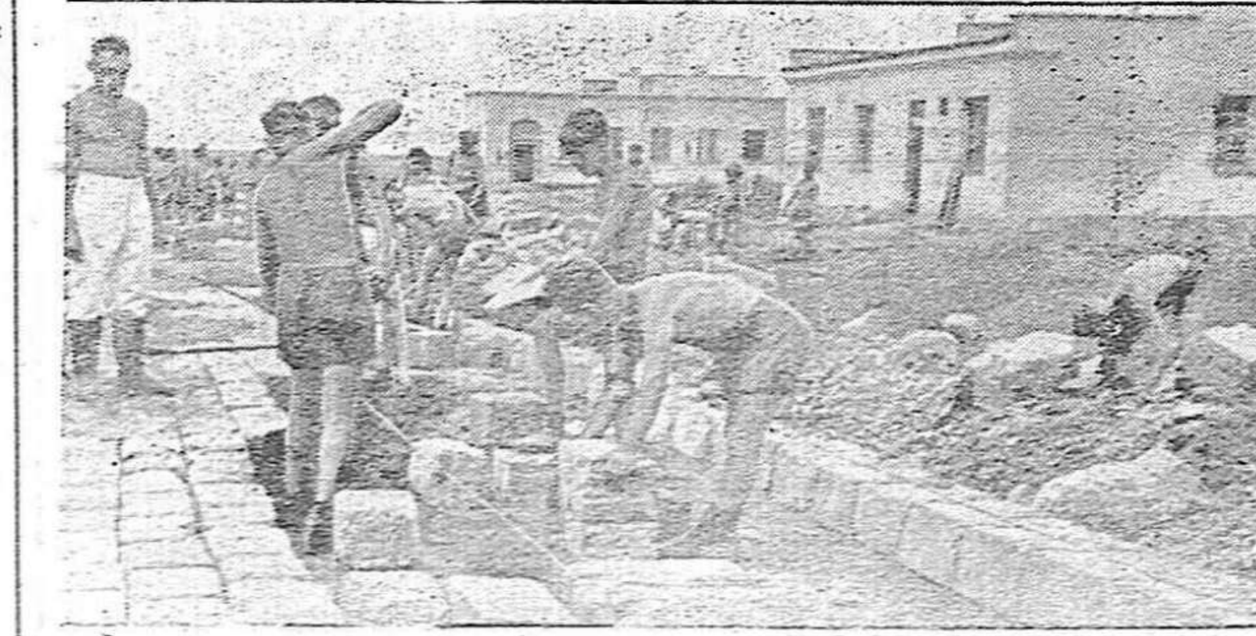
Muchachos alemanes del Servicio de Trabajo ayudan a los soldados en el frente del Este, construyendo carreteras para facilitar el tráfico de los vehículos.
