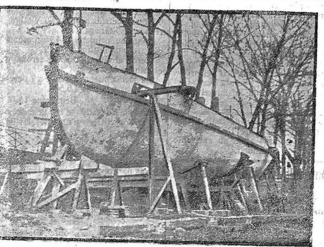
DE LA GUERRA.—Construcción de un barco de cemento armado.
