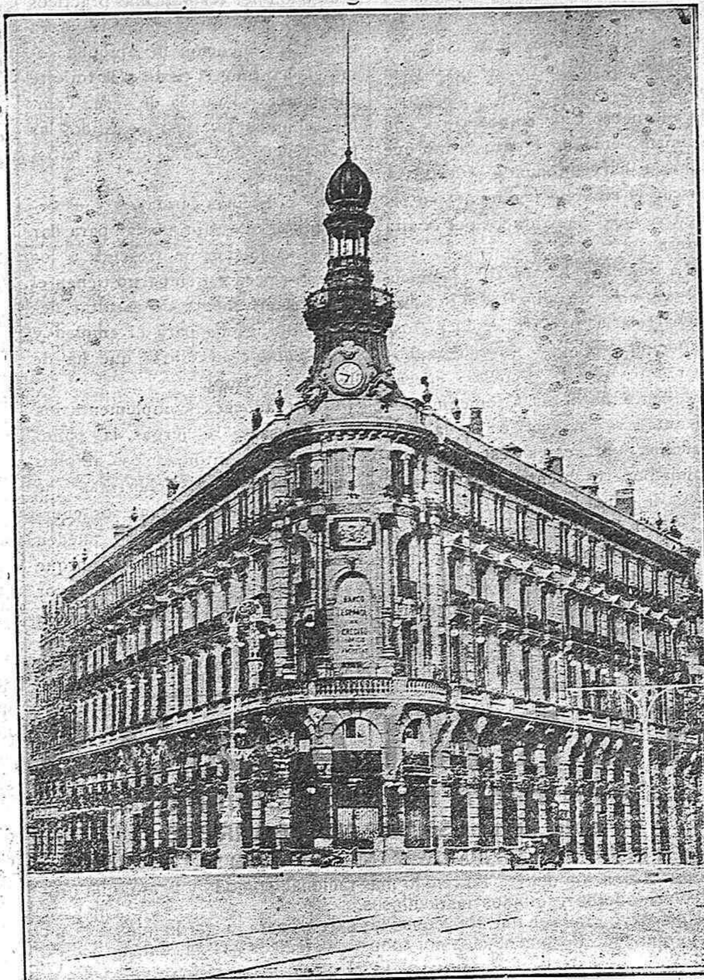
EDIFICIO PROPIEDAD DEL BANCO
