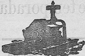
Nuevo aparato perfeccionado para extraer agua, aprovechando los ardores hasta la última gota del líquido, y con el más pequeño esfuerzo de las caballerías, por la disposición de la arza y por la suavidad de los rozamientos montados sobre armadura de cilindros.
