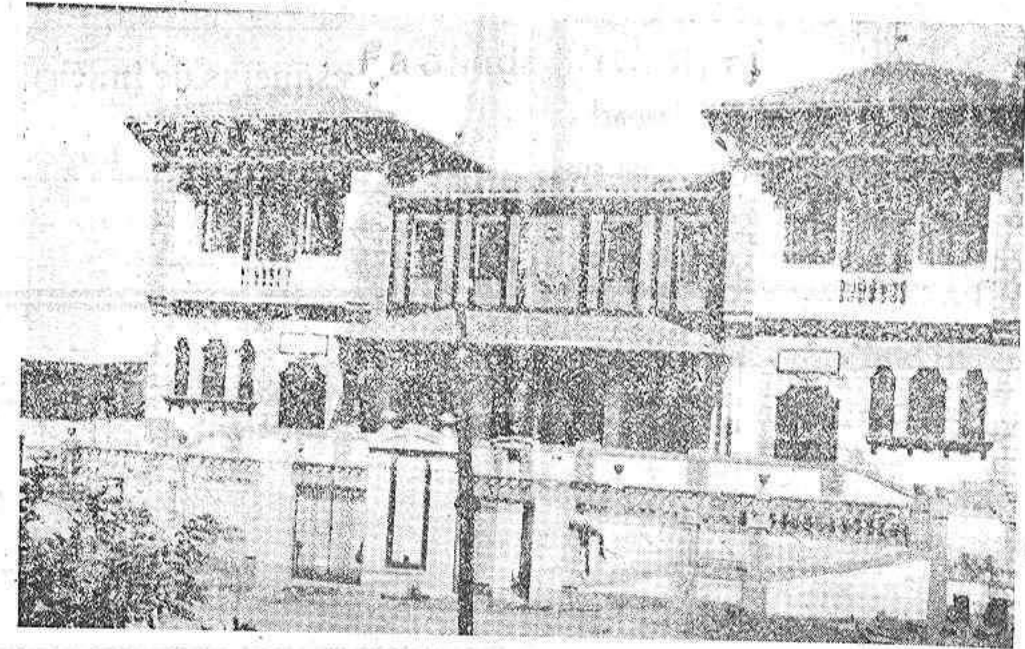
Fotografía del magnífico edificio escolar
