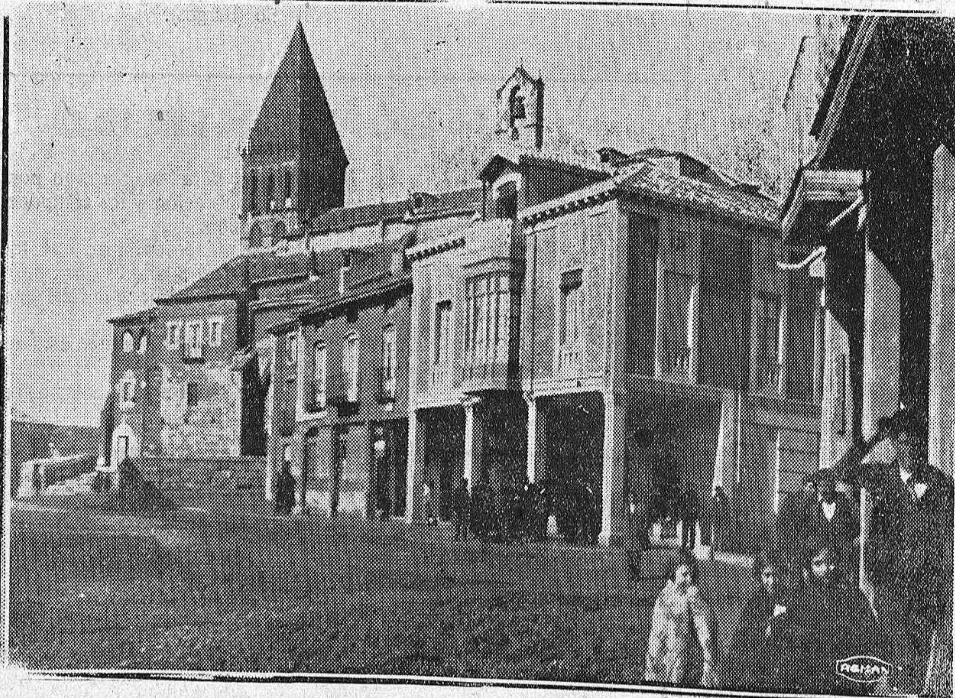
Un aspecto de Paredes de Nava
