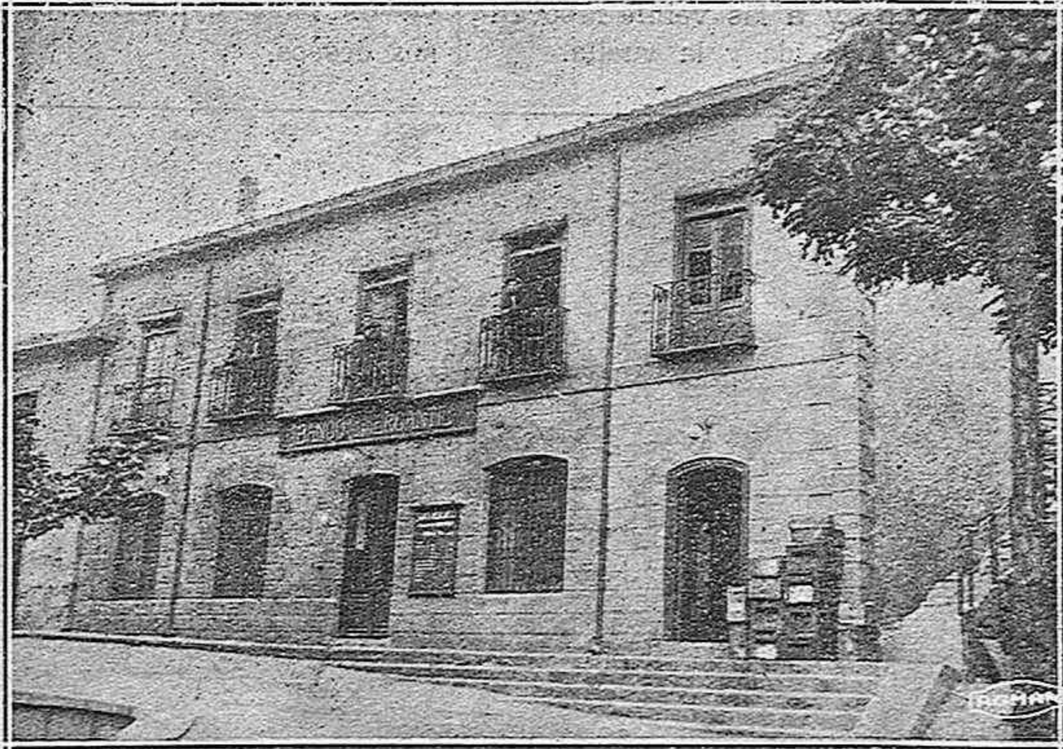
Edificio donde está instalado el Banco Mercantil en Barruelo
