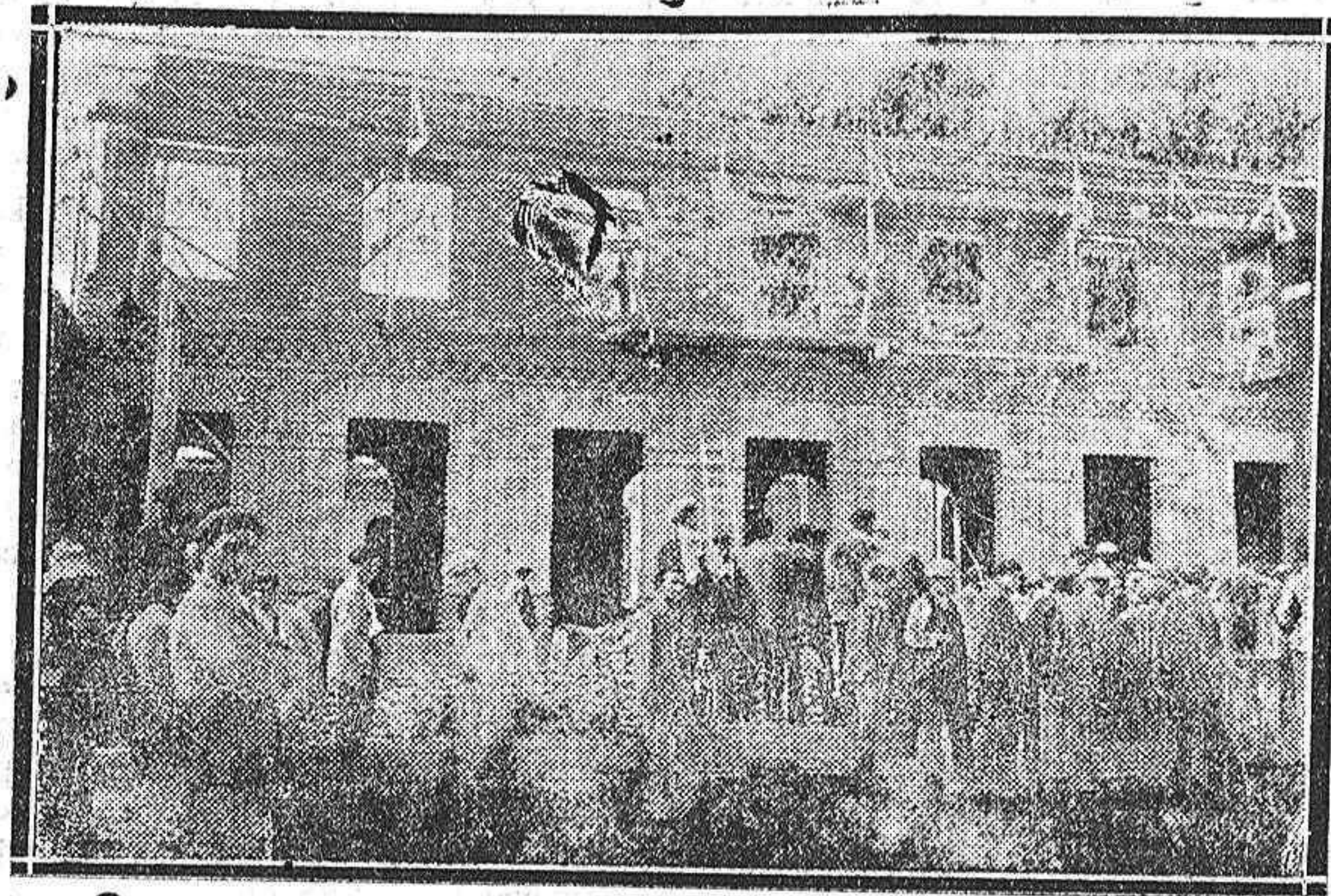
DEL ACCIDENTE DE HOY.—Los obreros congregados en el lugar del accidente de esta tarde, momentos después de ocurrido éste.
