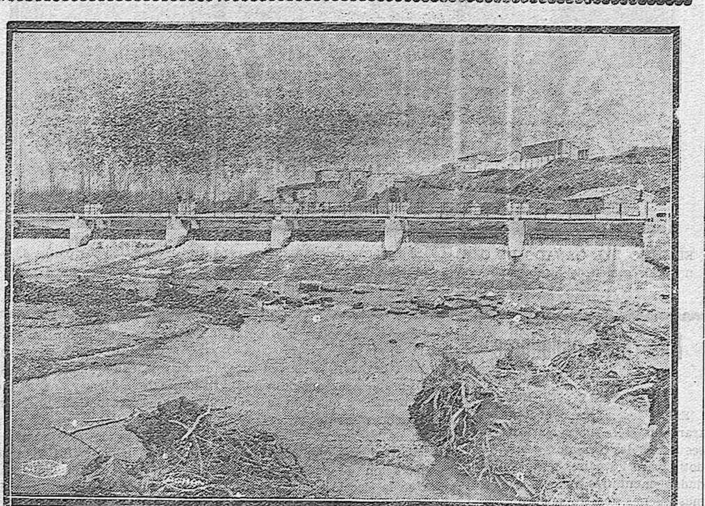
LAS OBRAS DE LA CONFEDERACION DEL DUERO.—Canal de Castilla.—Presa de alzas móviles en el cauce del río Carrión
