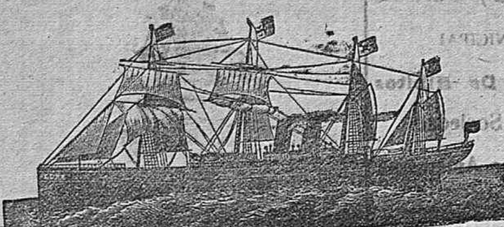
El nuevo y lujoso vapor correo, de 16,500 toneladas a dos máquinas y doble hélice provisto de telegrafía sin hilos y de todos los modernos adelantos
