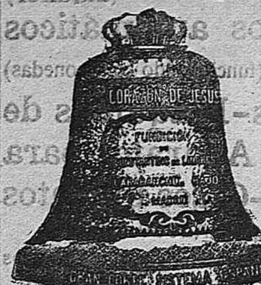
Aleación pura de cobre y estaño. Refundición de las rotas. Trazo matemático en toda forma de campana.
