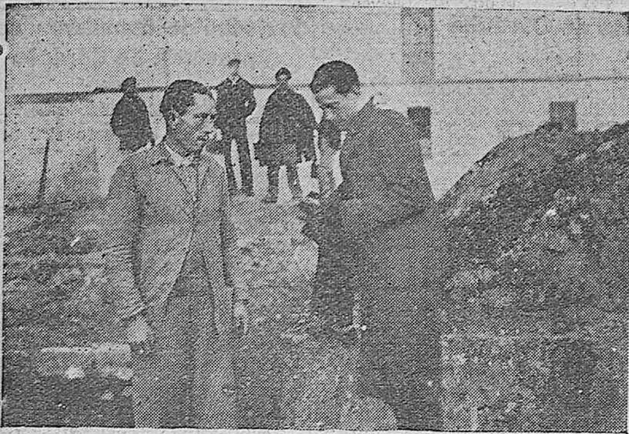
El guarda de las obras explicando algunos de los detalles relacionados con las excavaciones a nuestro compañero Díaz Pérez.
