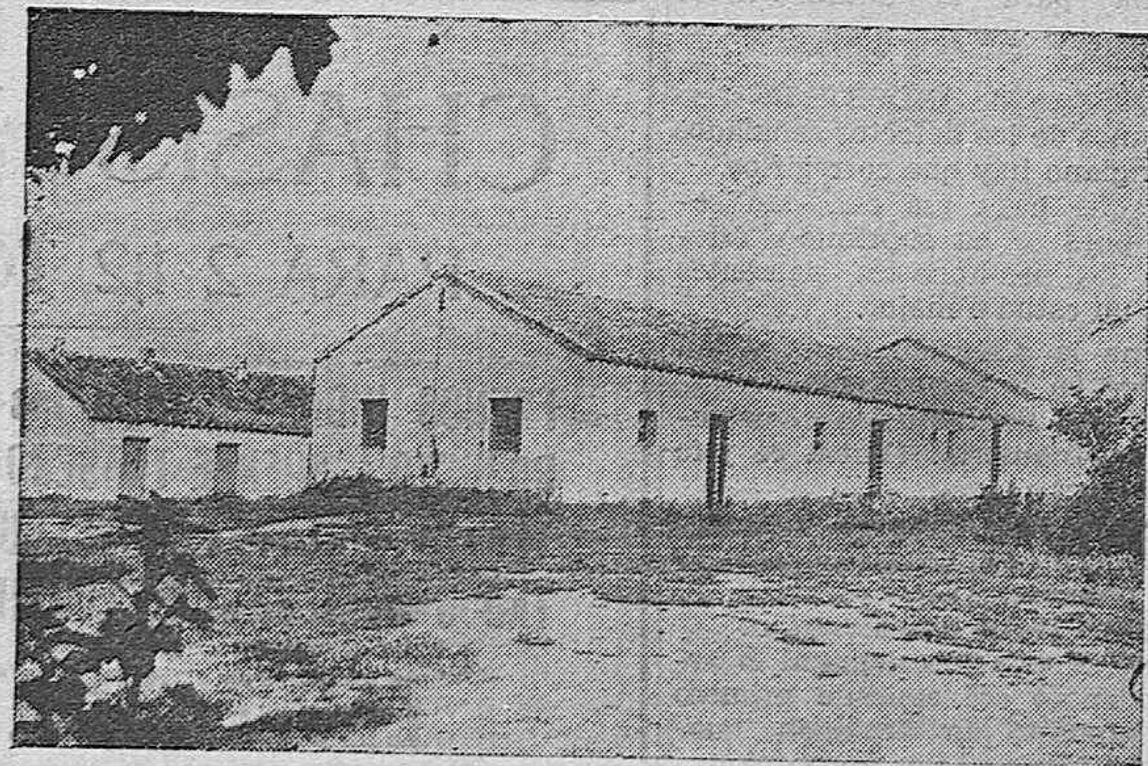
Vista de uno de los pabellones destinados a dormitorios que serán reformados por la Excm. Diputación provincial
