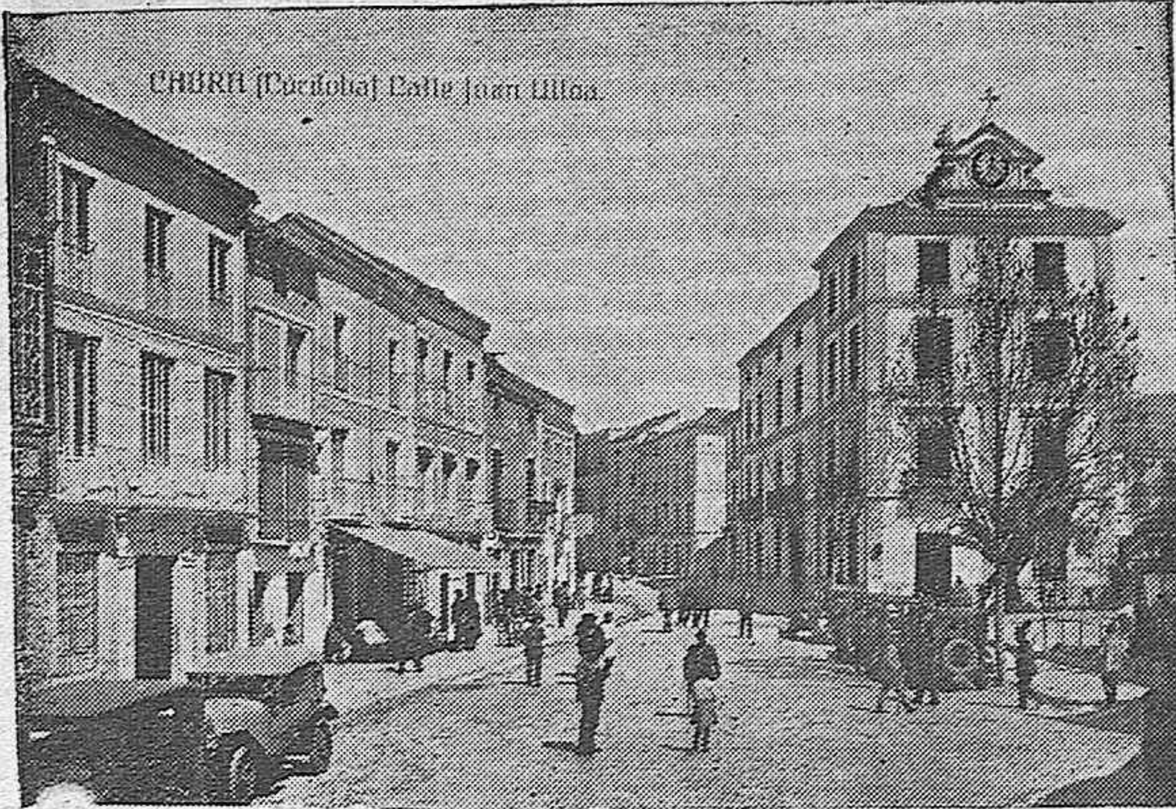
Calle de Juan Ulloa y Casa Ayuntamiento a su derecha.
