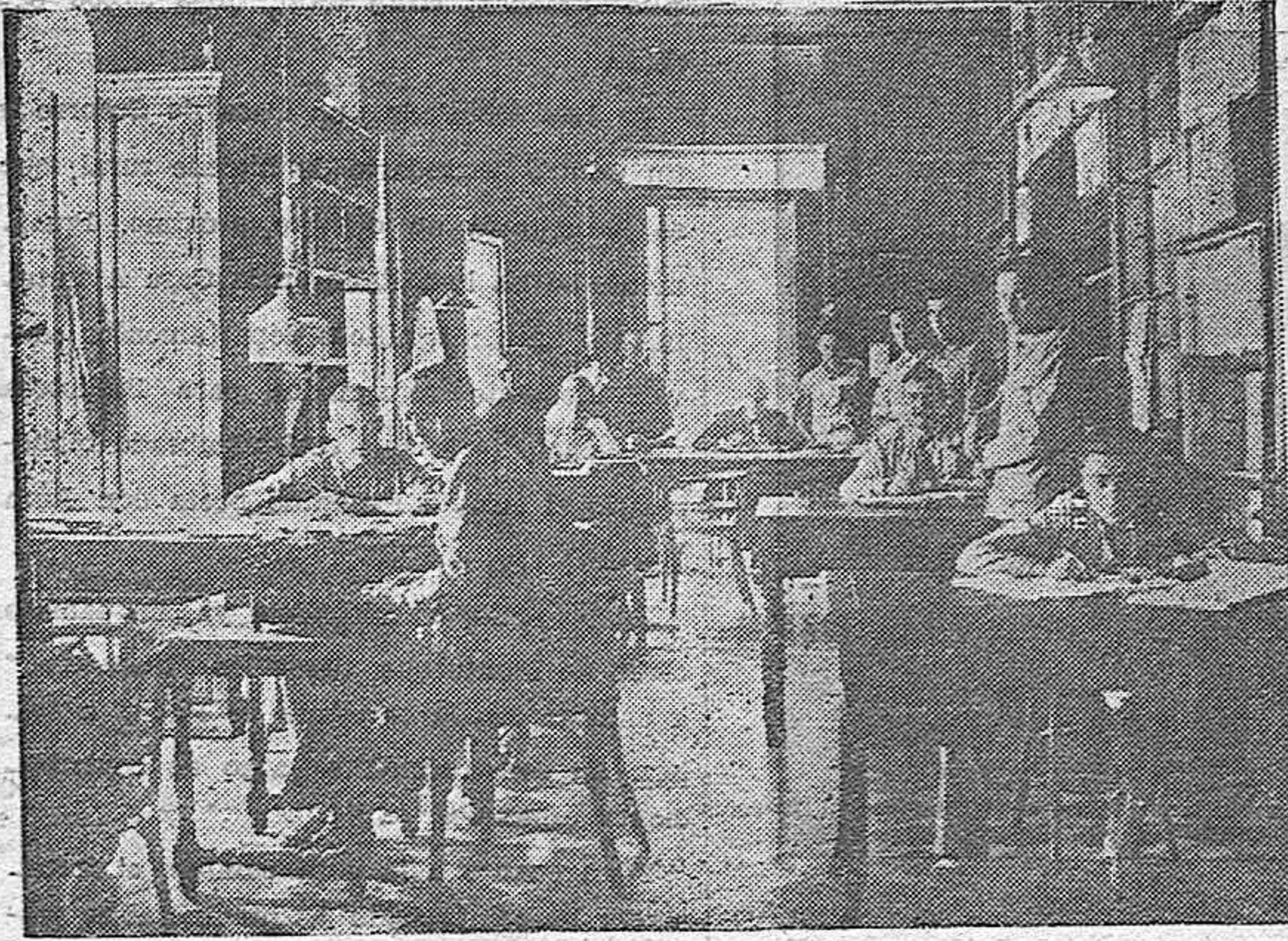
Vista de una de las oficinas municipales del Ayuntamiento de Cabra
