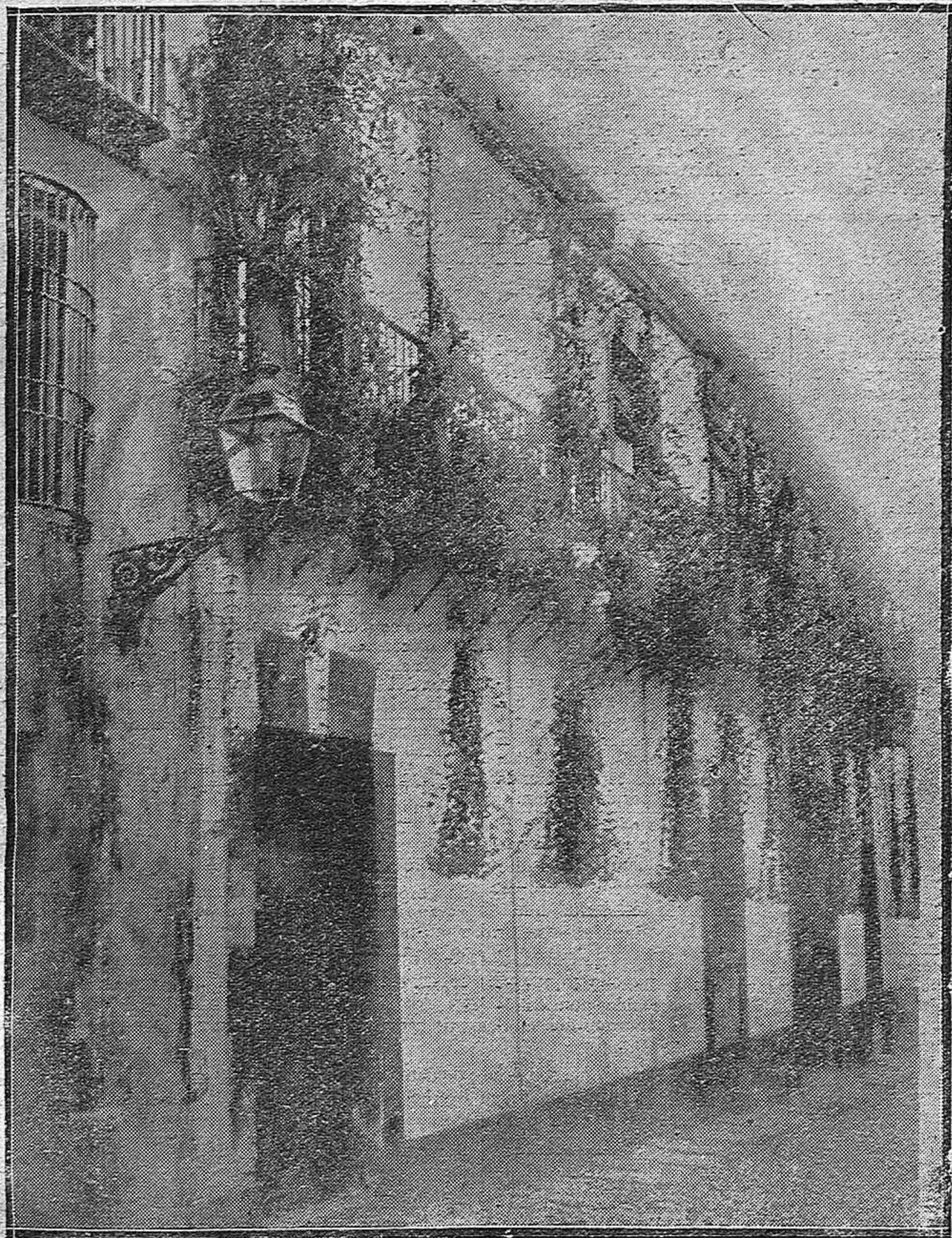
Un balcón típico cordobés que existe en la calle Caldereros, en la casa propiedad de don José Suárez
