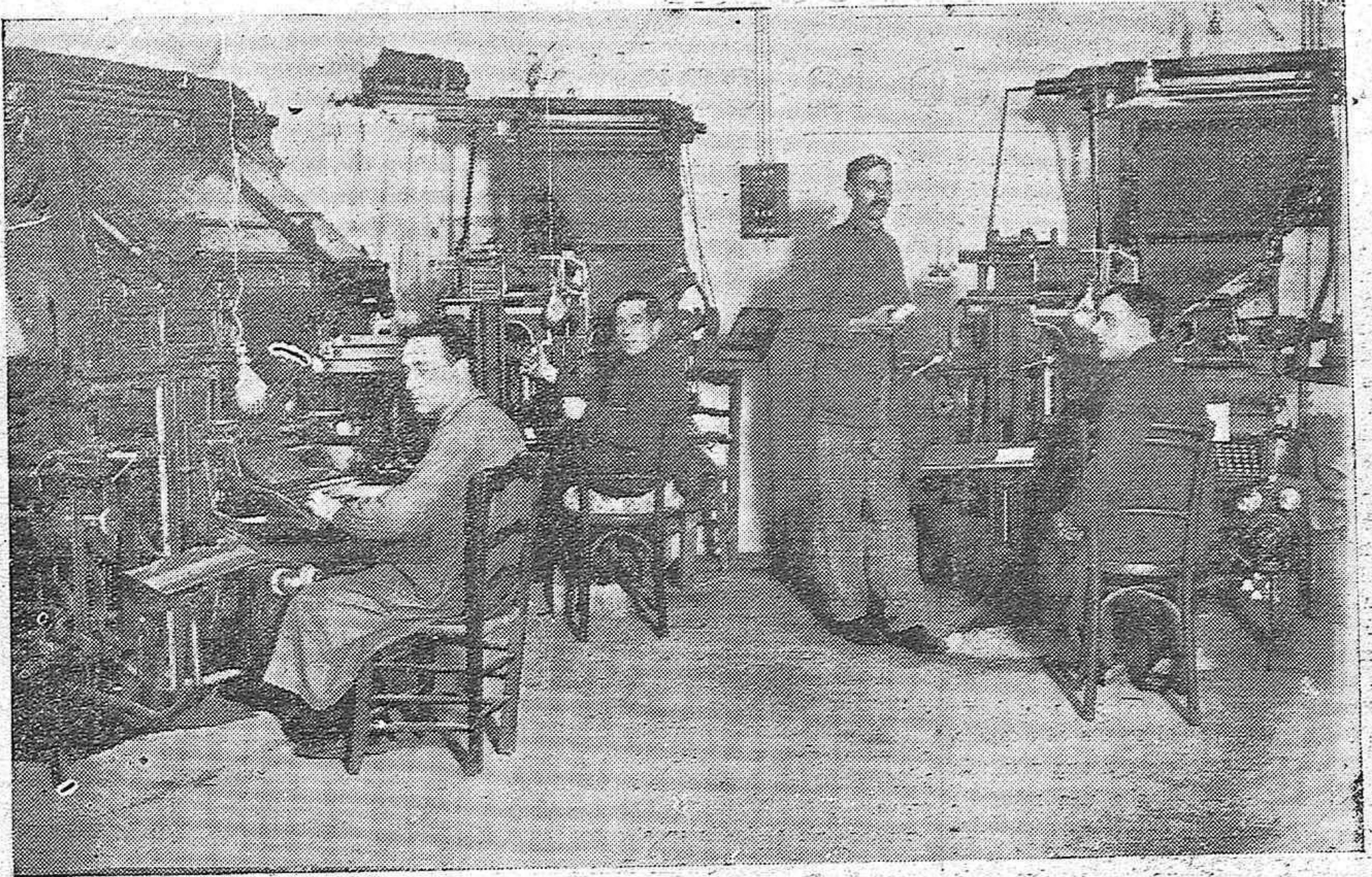
UN DETALLE DE LOS TALLERES. LAS LINOTIPIAS, CON SUS OBREROS LINOTIPISTAS, COMPONEN RÁPIDAMENTE COLUMNAS Y PLANAS DESDE SU COMPLICADO ORGANISMO, DANDO UNA FUERTE SENSACIÓN DE VIDA, DE ESA VIDA QUE LE IMPRIME LA ACTUACIÓN INTELIGENTE DEL OBRERO.
