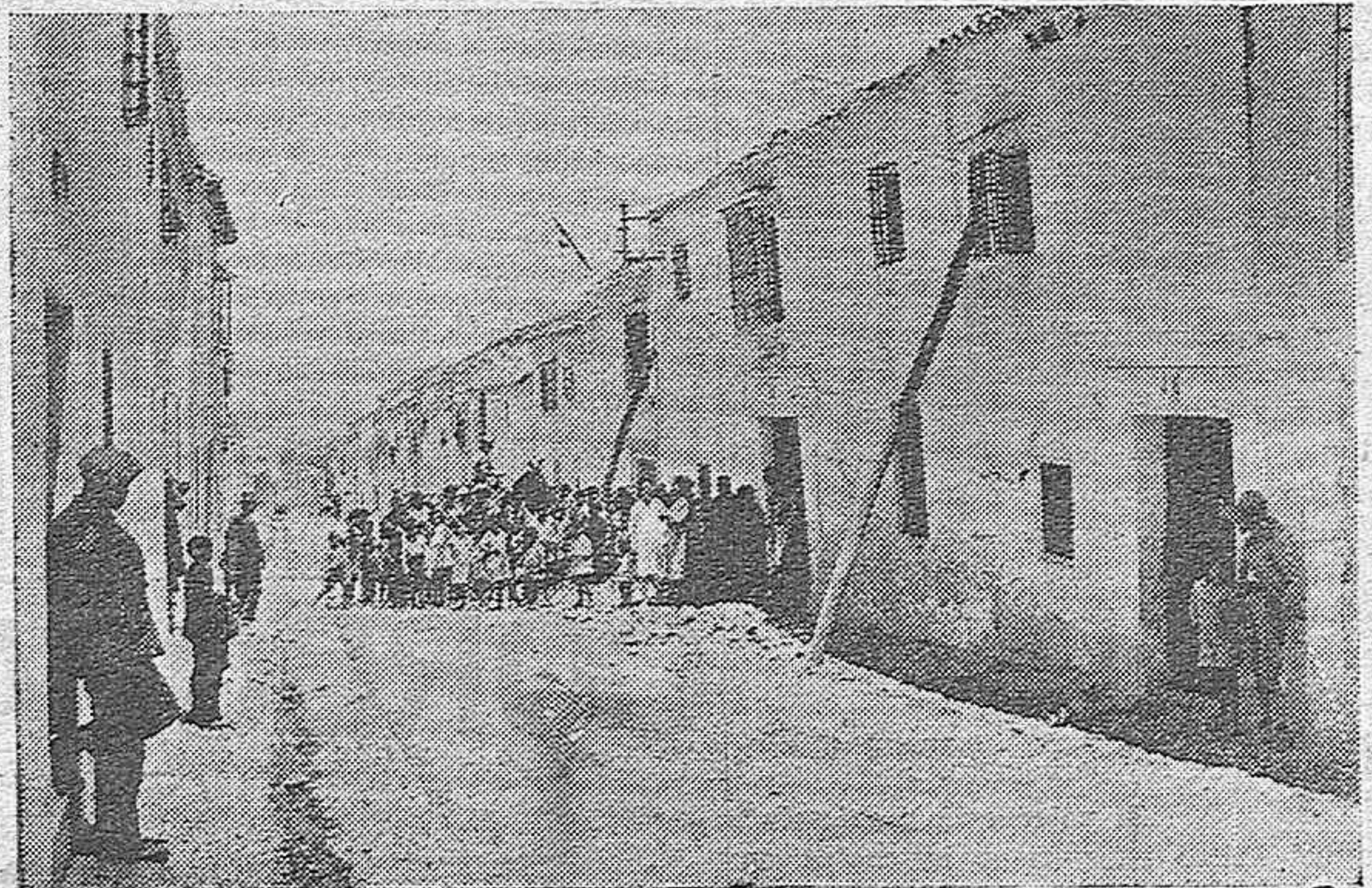
EL TERREMOTO EN MONTILLA.—LA CALLE DE SANTA BRÍGIDA, UNA DE LAS MÁS CASTIGADAS POR EL MOVIMIENTO SÍSMICO, Y QUE EN CASI SU TOTALIDAD SE ENCUENTRA CON ENORMES DESPERFECTOS.
