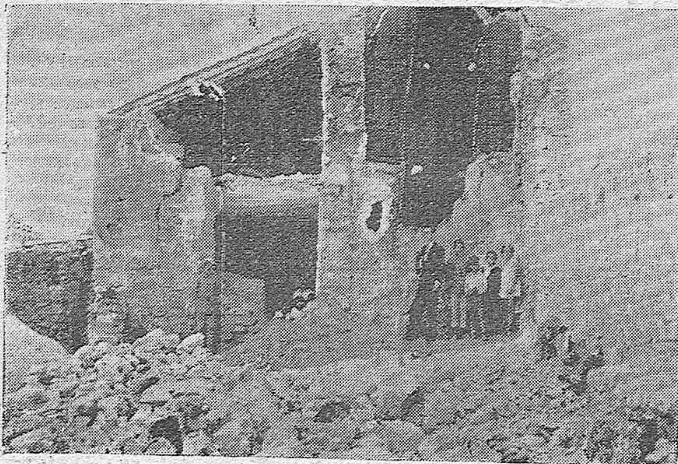
EL TERREMOTO EN MONTILLA.—ESTADO EN QUE HA QUEDADO LA CASA NÚMERO 24 DE LA CALLE DE SAN FRANCISCO, OCUPADA POR LA FAMILIA DE DULCE GÓMEZ.
