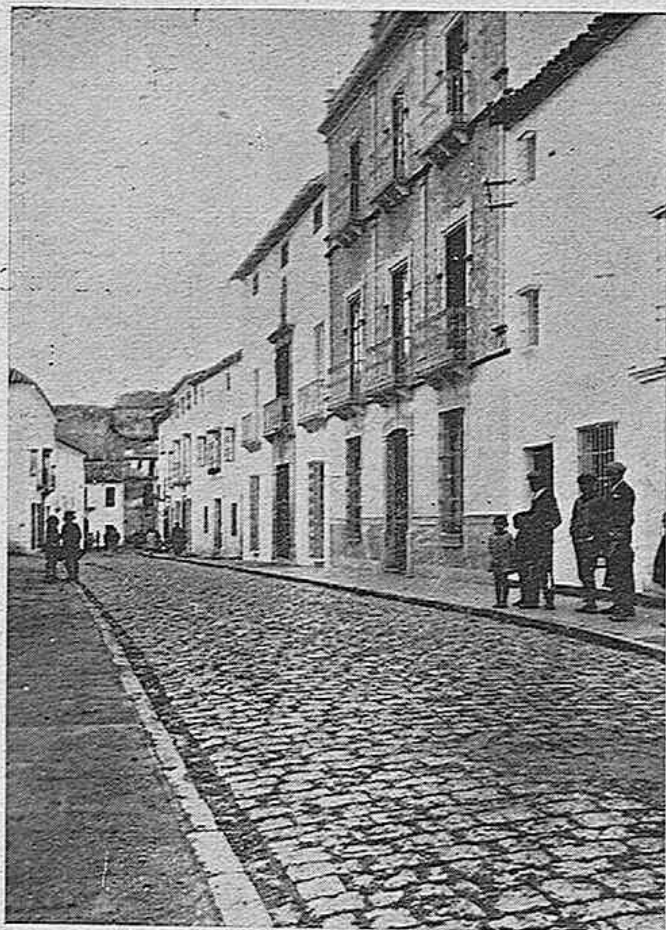
La calle Ancha en la que se encuentra la Casa de los Valdelomar
