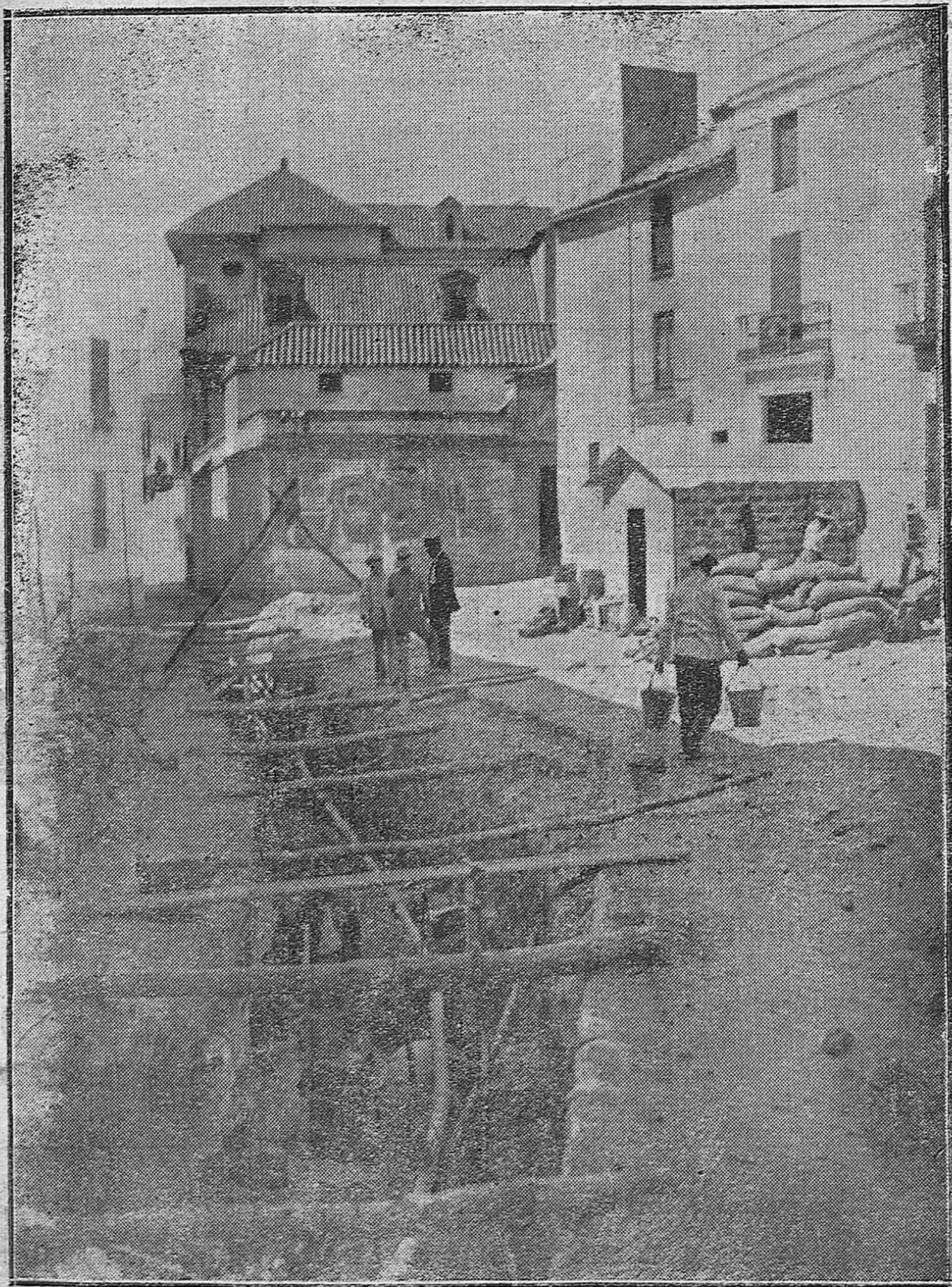
EL NUEVO ALCANTARILLADO QUE SE CONSTRUYE EN LA PLAZA DE SAN FELIPE, CUYAS OBRAS CONSTITUYEN UN SERIO PELIGRO PARA AQUELLAS PERSONAS QUE TIENEN NECESIDAD DE TRANSITAR POR DICHO LUGAR A MEDIA NOCHE A CAUSA DE LA FALTA DE ALUMBRADO.
