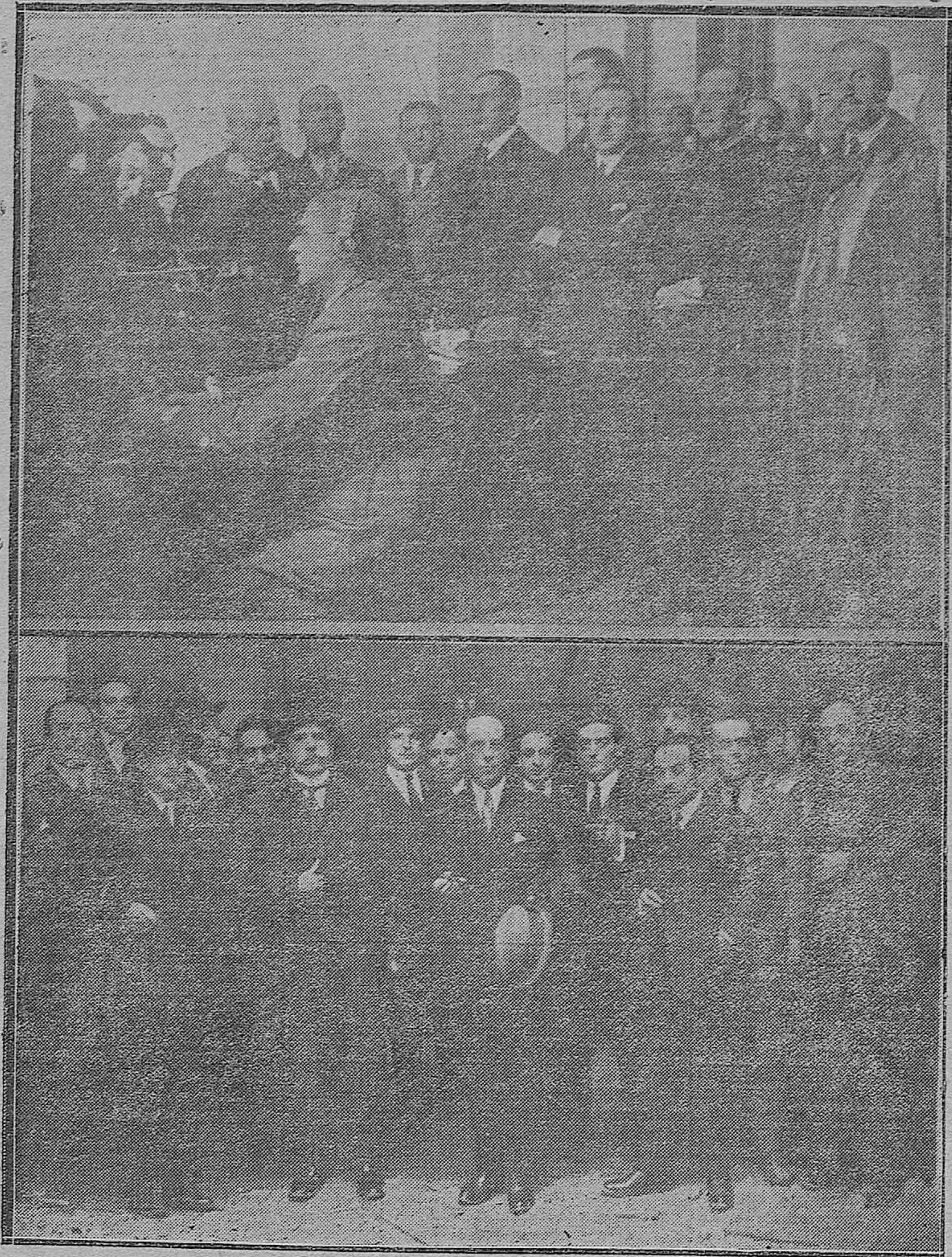
AGUILAR DE LA FRONTERA.—El gobernador civil señor Cabello Lapiedra en el acto de Inaugurar aquella estación telefónica.--2) Las autoridades locales y de la provincia al terminar el banquete con que fueron obsequiadas por la Compañía Nacional de Telefonía.
