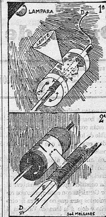
La segunda figura es el aparato receptor: D, hilo, del transmisor; F, hilo de Geissler; E, cilindro con la película para recibir la imagen.
