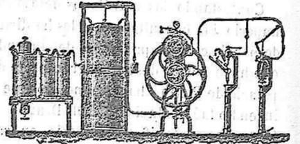
Aparatos para hacer gaseosas, continuo con embotelladoras en columnas independientes.
