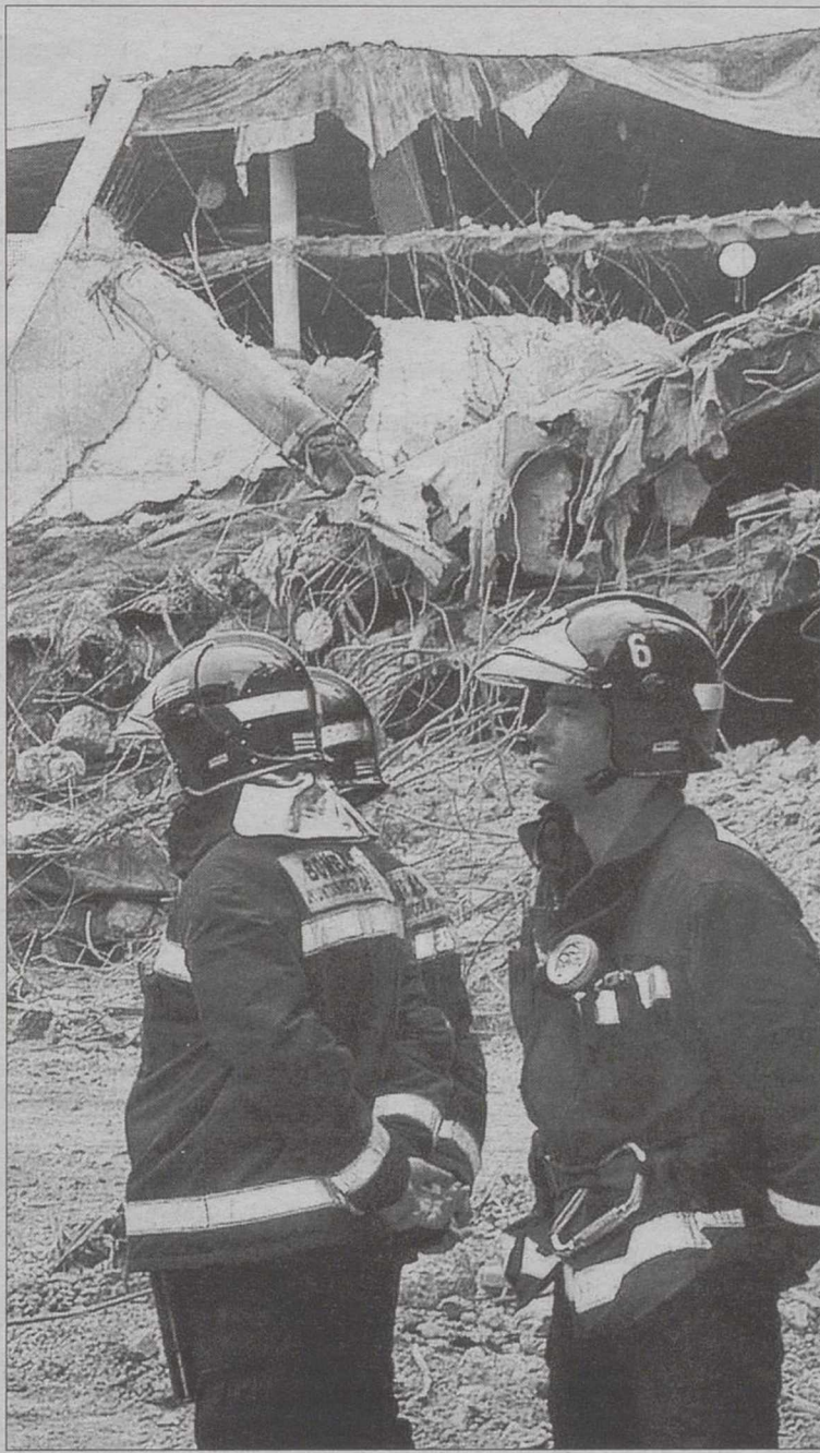
Varios bomberos contemplan la devastación causada por la bomba de ETA. / EFE
