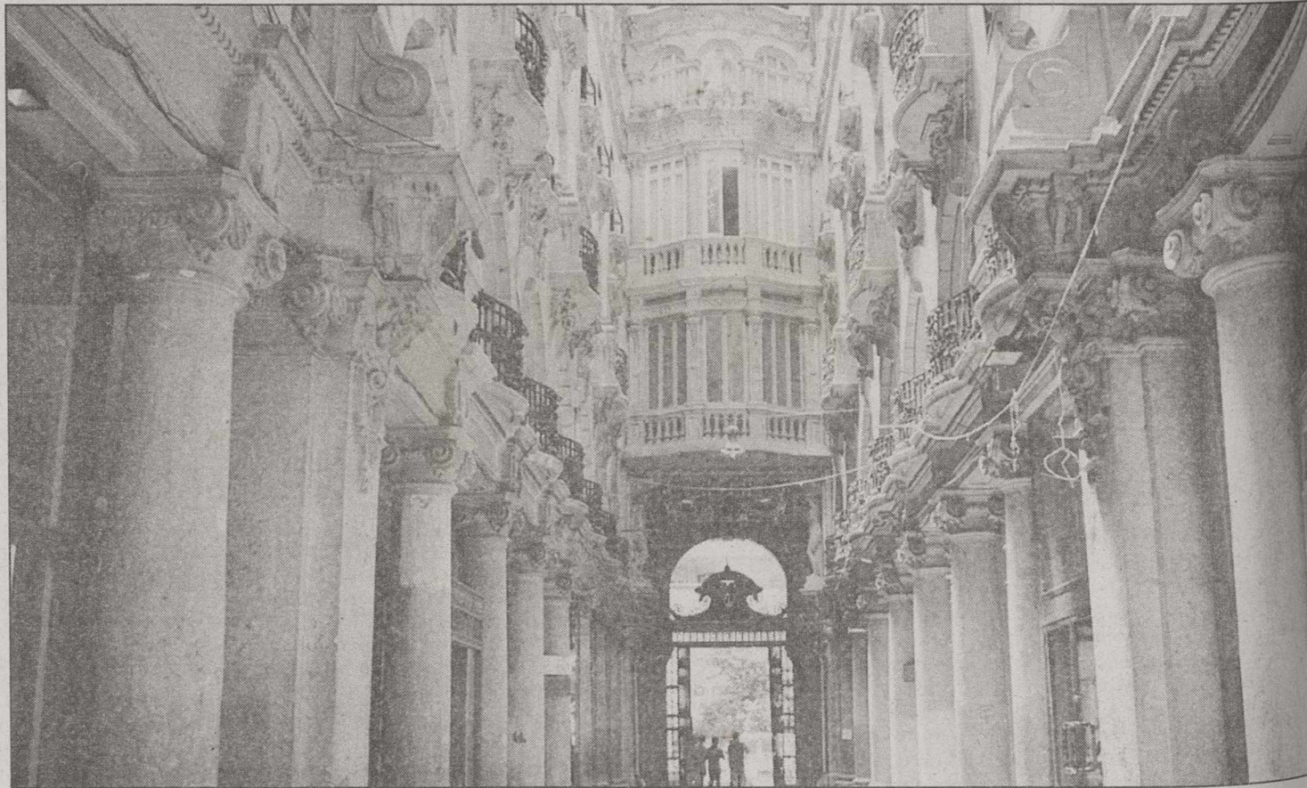
El Pasaje de Lodares durante las recientes obras de remodelación.
