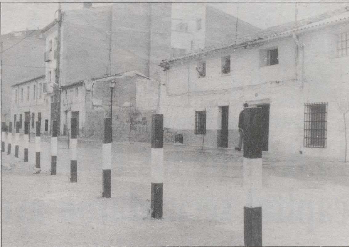
El incendio fue en la techumbre de una casa deshabitada. Las casas en ruinas es otro de los problemas del barrio.
