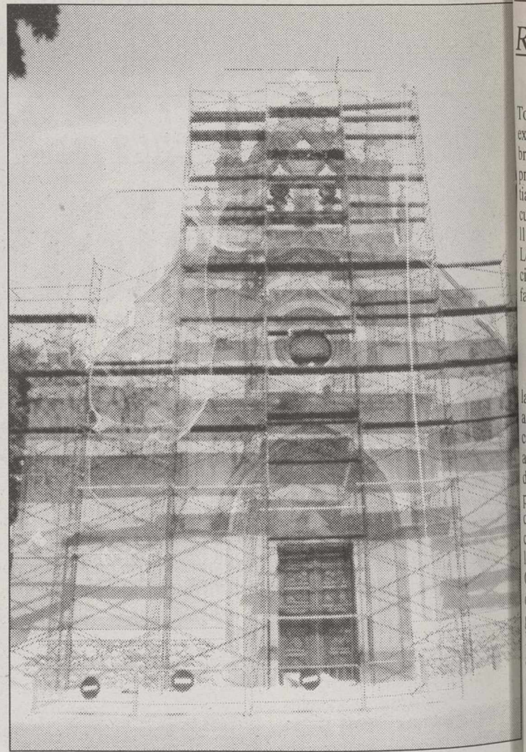
Restauración de la iglesia Santa Catalina.
