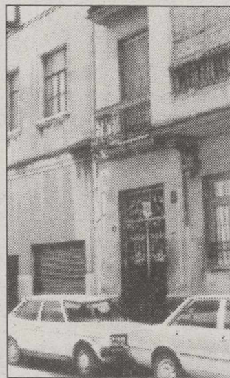
Viviendas en mal estado.
