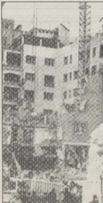
La antigüedad causó el derrumbe.
