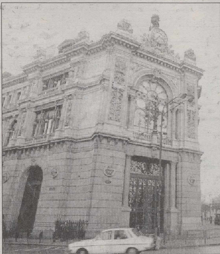
Fachada del Banco de España.
