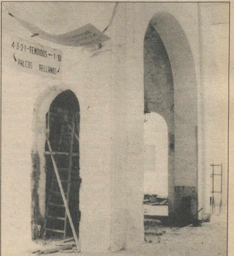
Las obras no estarán concluidas para la corrida de Asprona.
