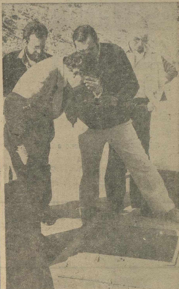
Abajo están los contadores que indican la entrada de agua por la boca del túnel de Talave. A la salida, otros contadores señalan una cantidad superior. Es el agua que se llevan los murcianos.
