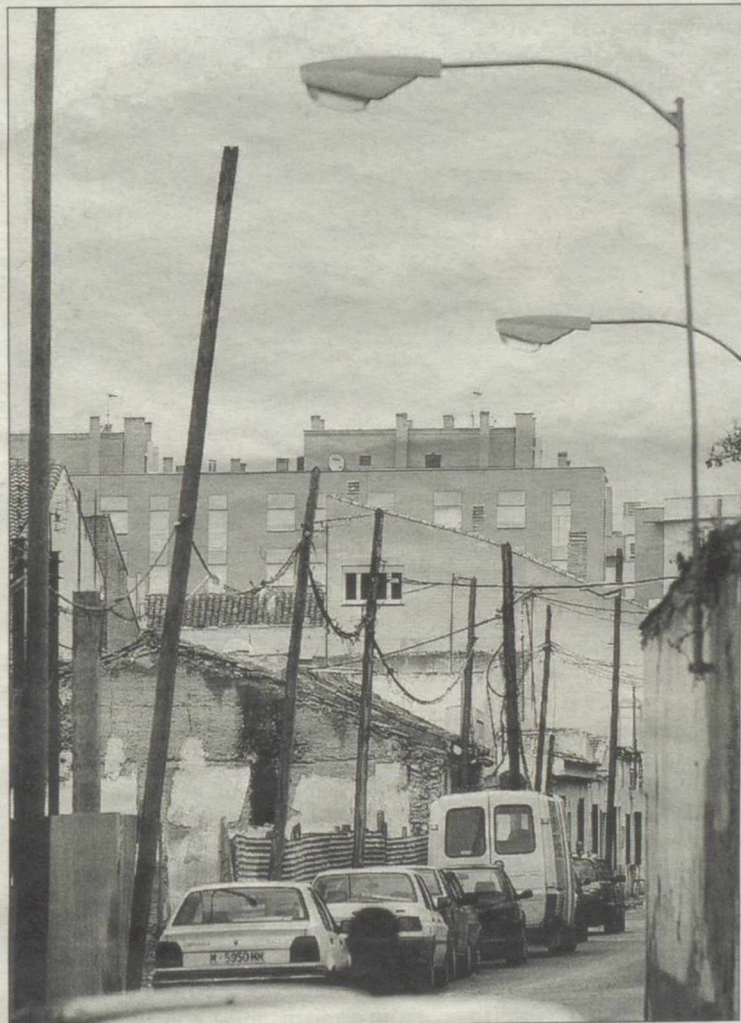
La calle Ángel, donde se derriban unos edificios y se levantan otros.
